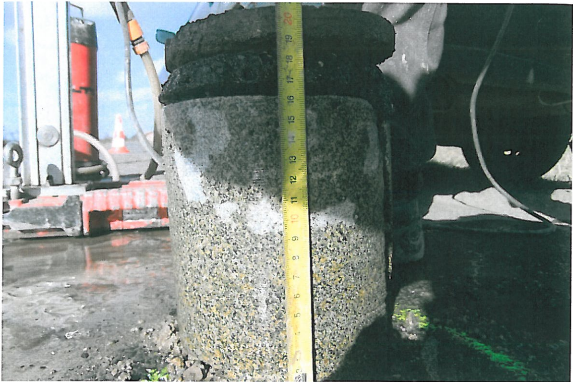
Fot . 48. Pobieranie odwiertu Nr 8 w km 1+370, pas prawy
