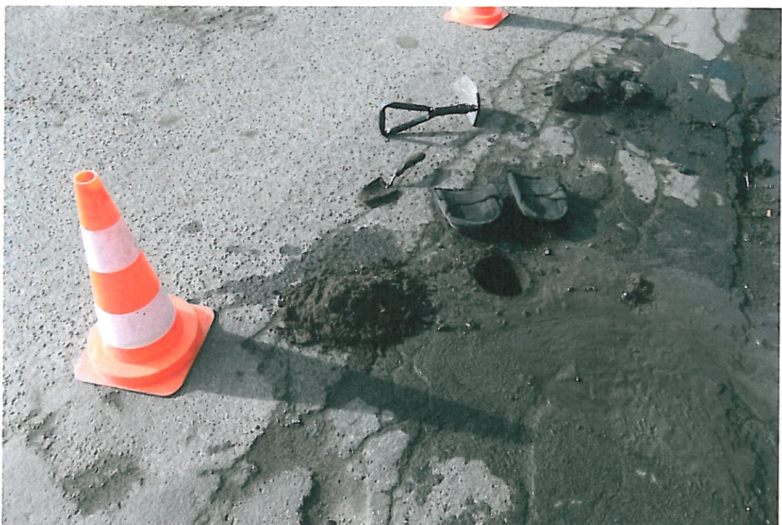
Fot . 9. Widok odkrywki Nr 1 w km 0+000, kruszywo z podbudowy.
