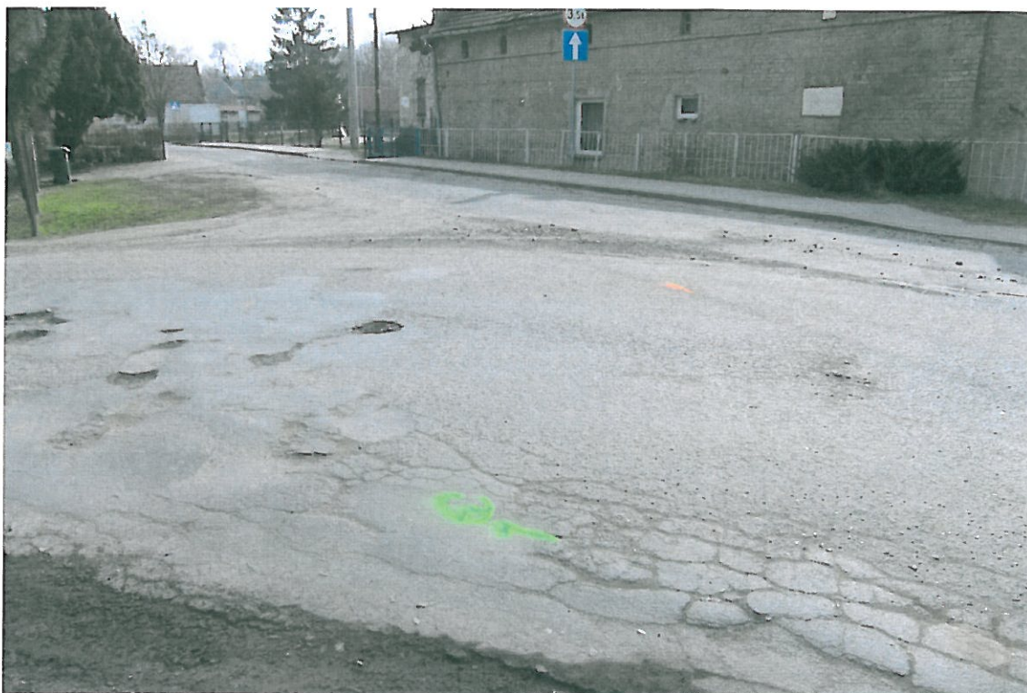
Fot . 6. Lokalizacja odkrywki Nr 1 w km 0+000, pas lewy
