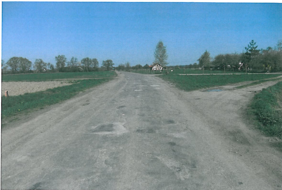
Fot . 26. Widok odcinka drogi Gosławice – Prężyce, km 1+400.
