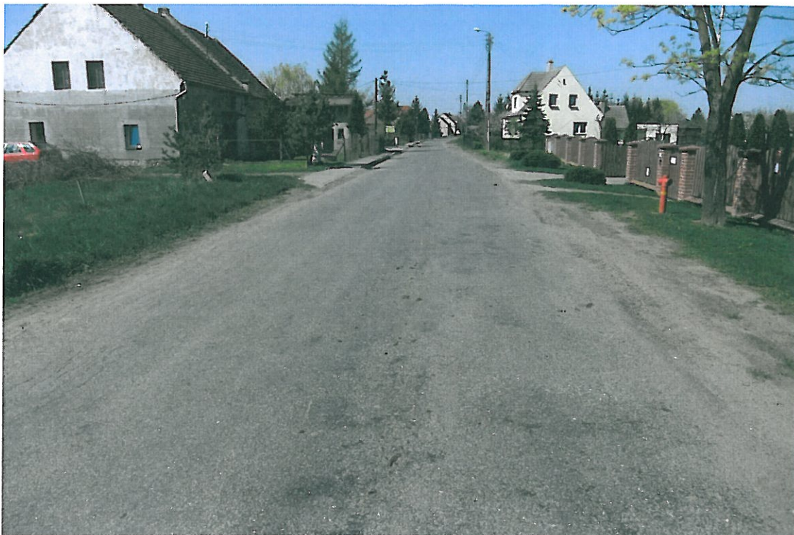
Fot . 68. Widok odcinka drogi Prężyce - Lenartowice, km 4+600.
