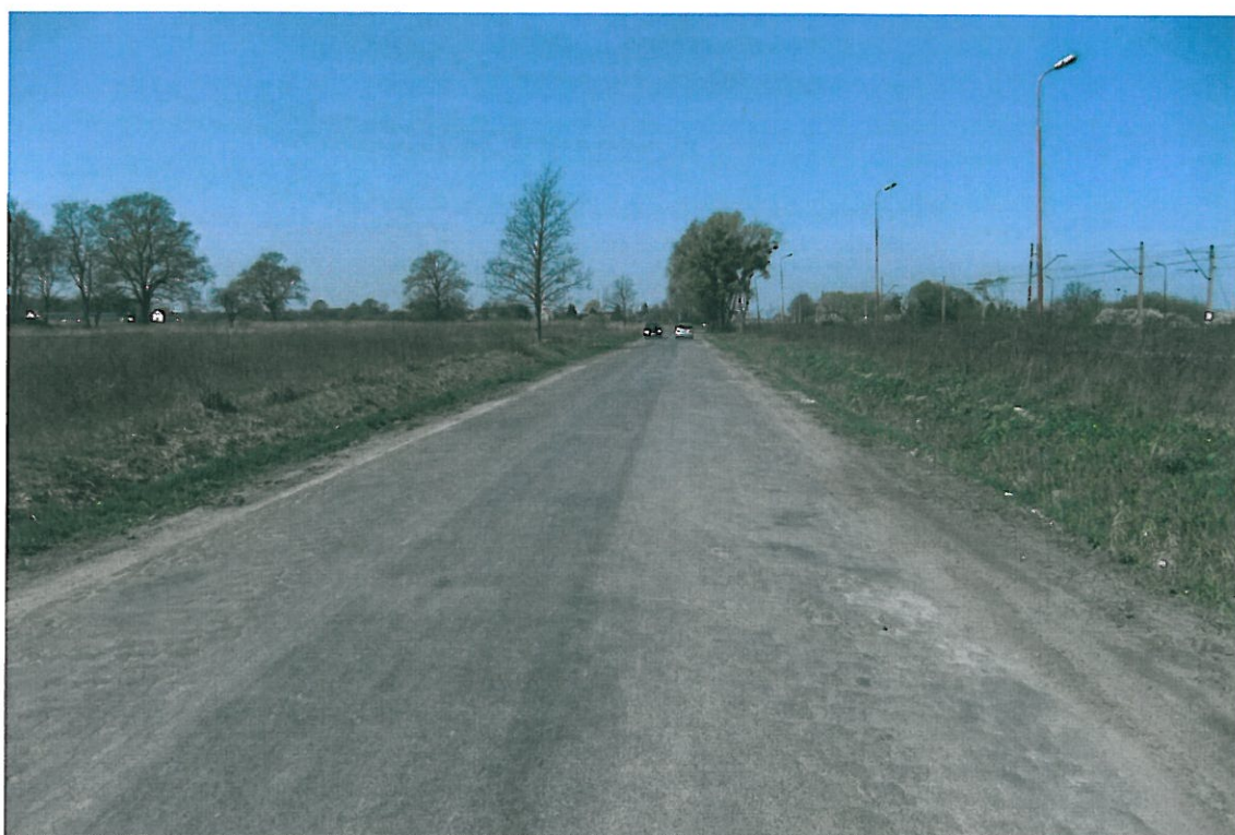
Fot . 21. Widok odcinka drogi – Gosławice - Prężyce, km 0+400.
