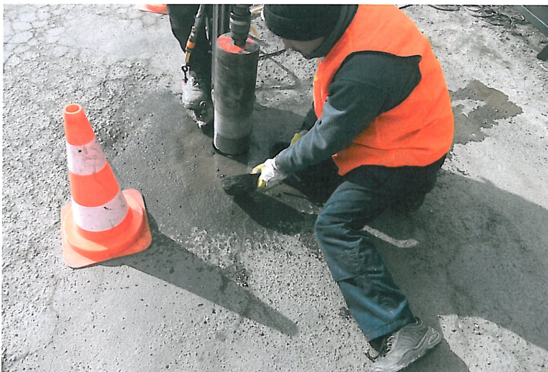
Fot . 17. Widok odwiertu Nr 3 w km 0+750, pas lewy
