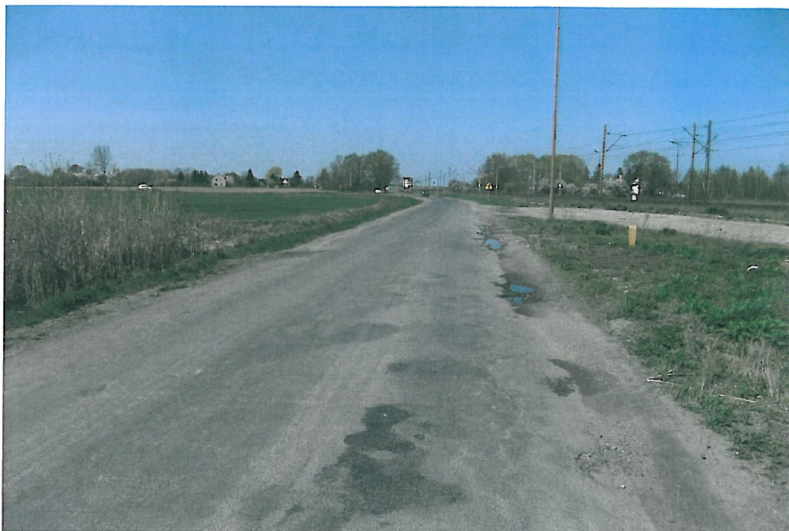
Fot . 22. Widok odcinka drogi Gostawice - Prężyce, km 0+600.
