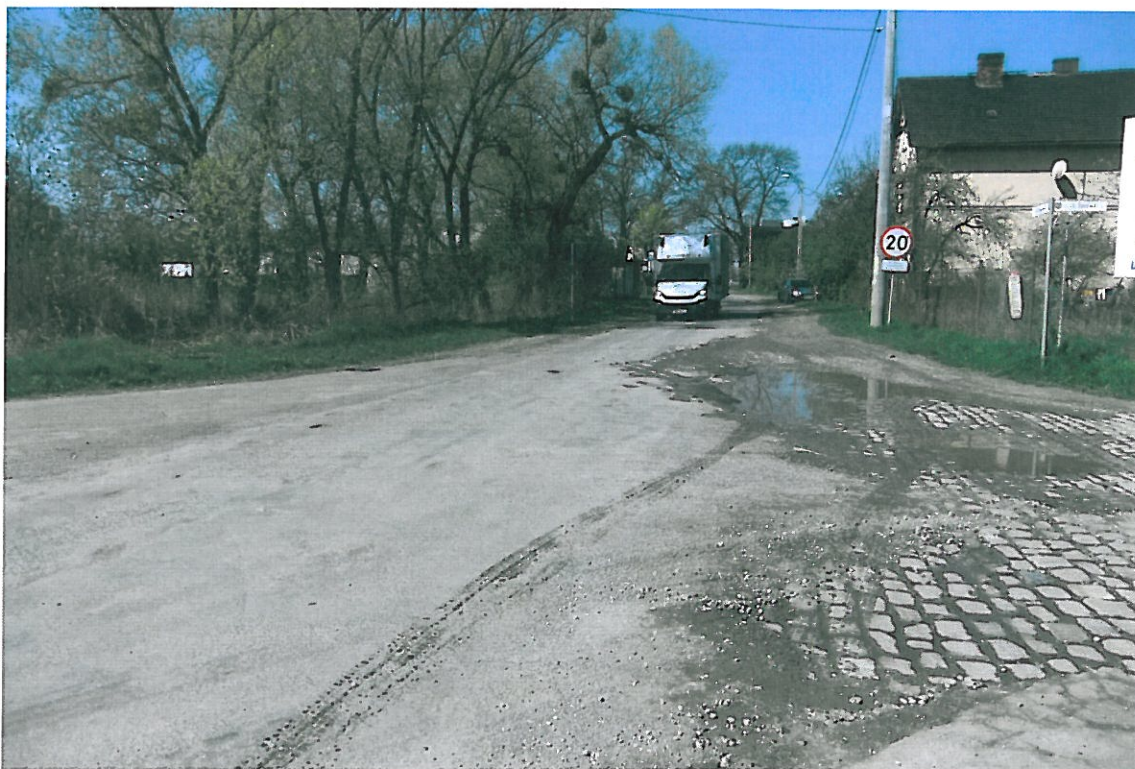
Fot . 19. Widok odcinka drogi w miejscowości Gosławice ( km 0+000).
