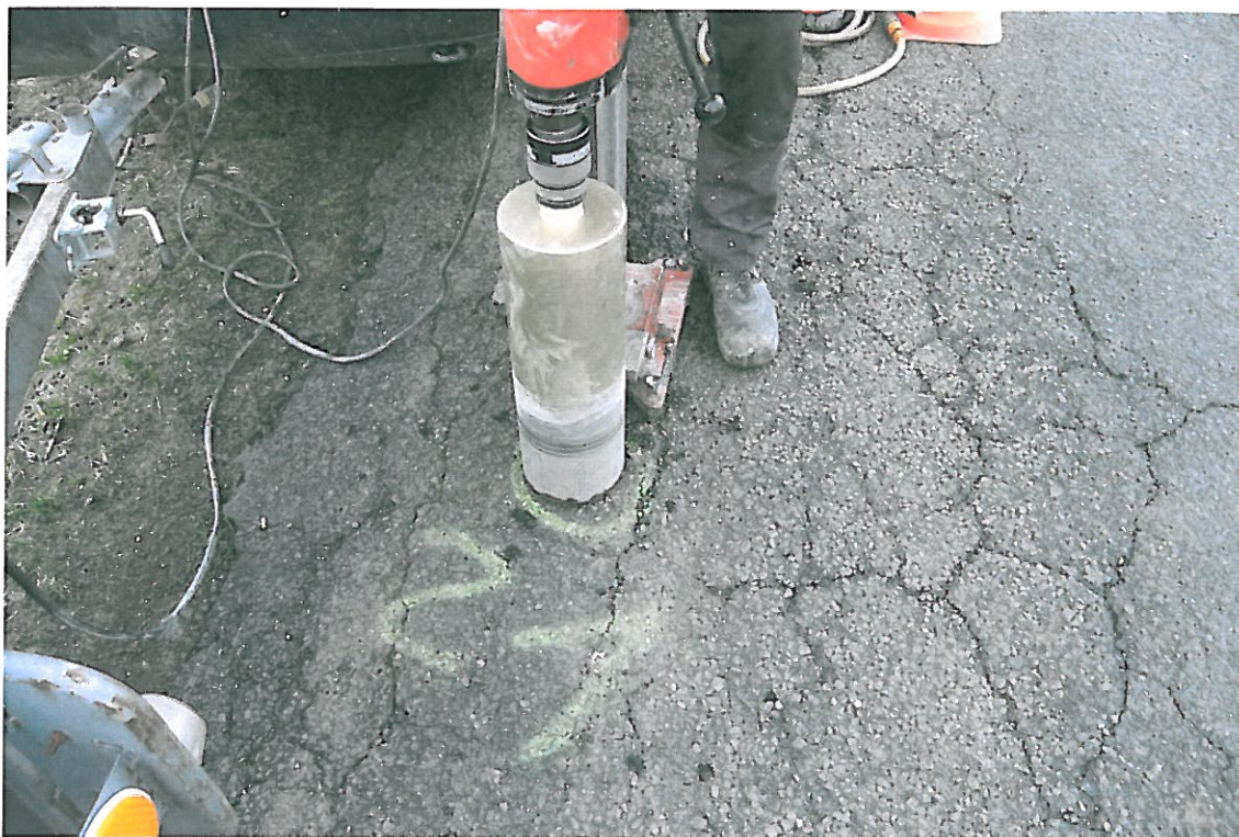
Fot . 108. Lokalizacja odkrywki Nr 21 w km 6+000, pas lewy
