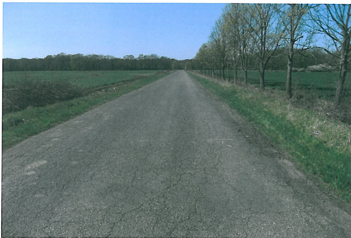
Fot . 90. Widok odcinka drogi Lenartowice - Księginice, km 6+100.
