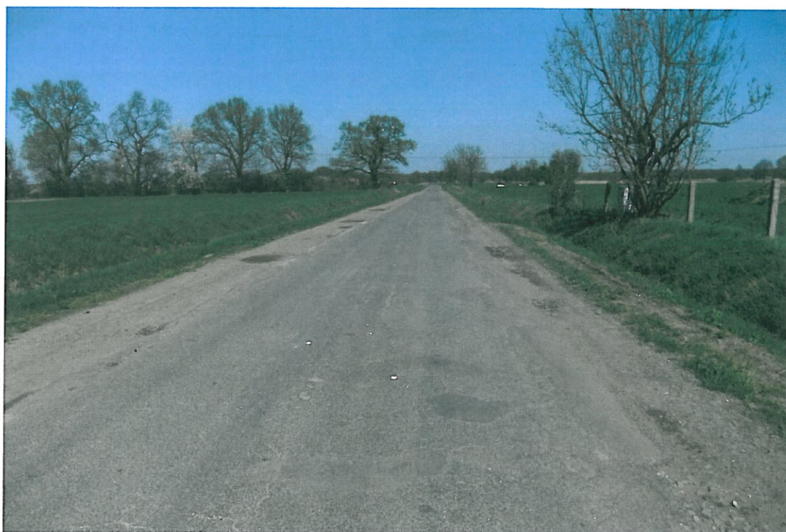
Fot . 27. Widok odcinka drogi Gosławice – Prężyce, km 1+600.
