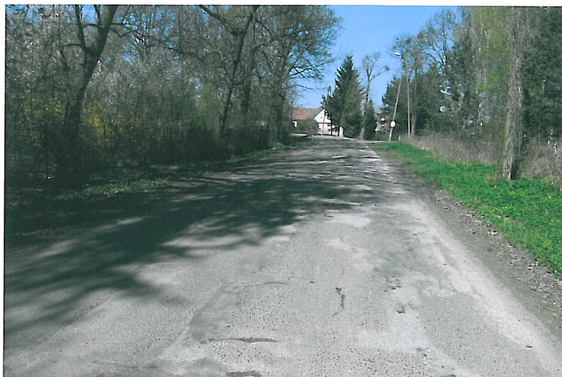
Fot . 59. Widok odcinka drogi Prężyce - Lenartowice, km 2+800.
