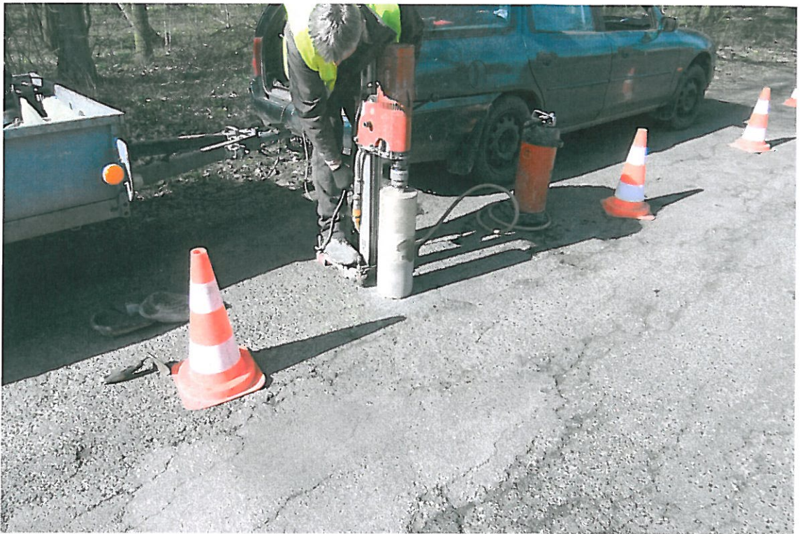
Fot . 127. Lokalizacja odkrywki Nr 25 w km 7+400, pas lewy
