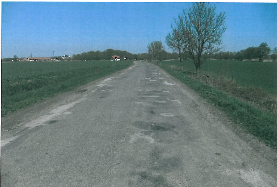
Fot . 29. Widok odcinka drogi Gosławice – Prężyce, km 2+000.
