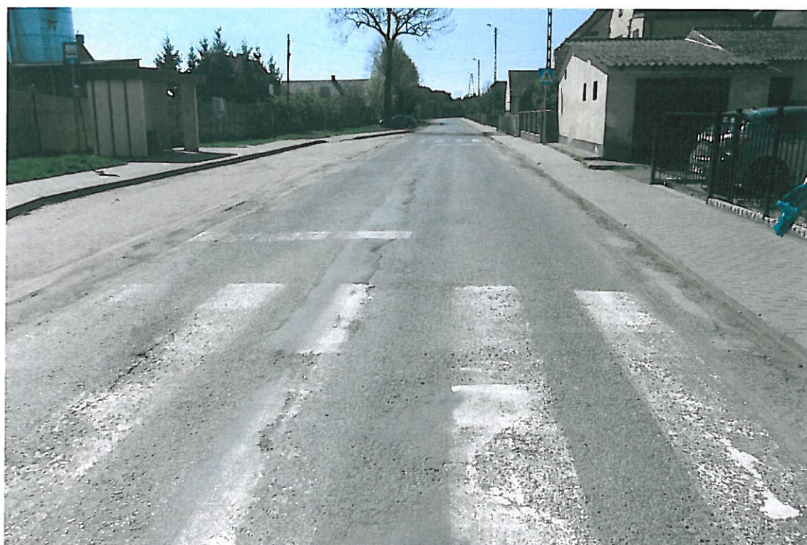
Fot . 61. Widok odcinka drogi Prężyce - Lenartowice, km 3+200.
