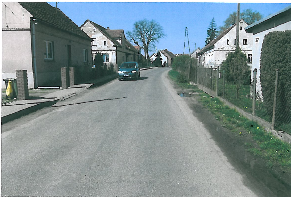
Fot . 84. Widok odcinka drogi Lenartowice - Księginice ( km 4+900 ).
