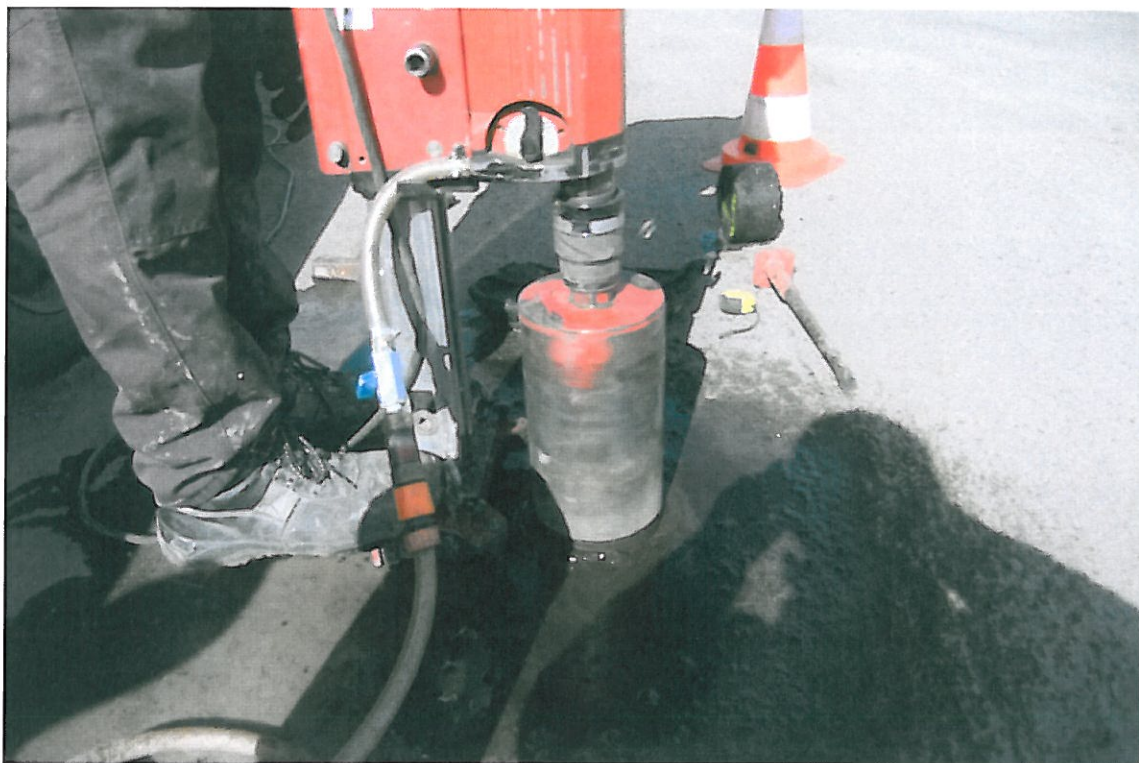
Fot . 32. Pobieranie odwiertu Nr 4 w km 0+000, pas lewy
