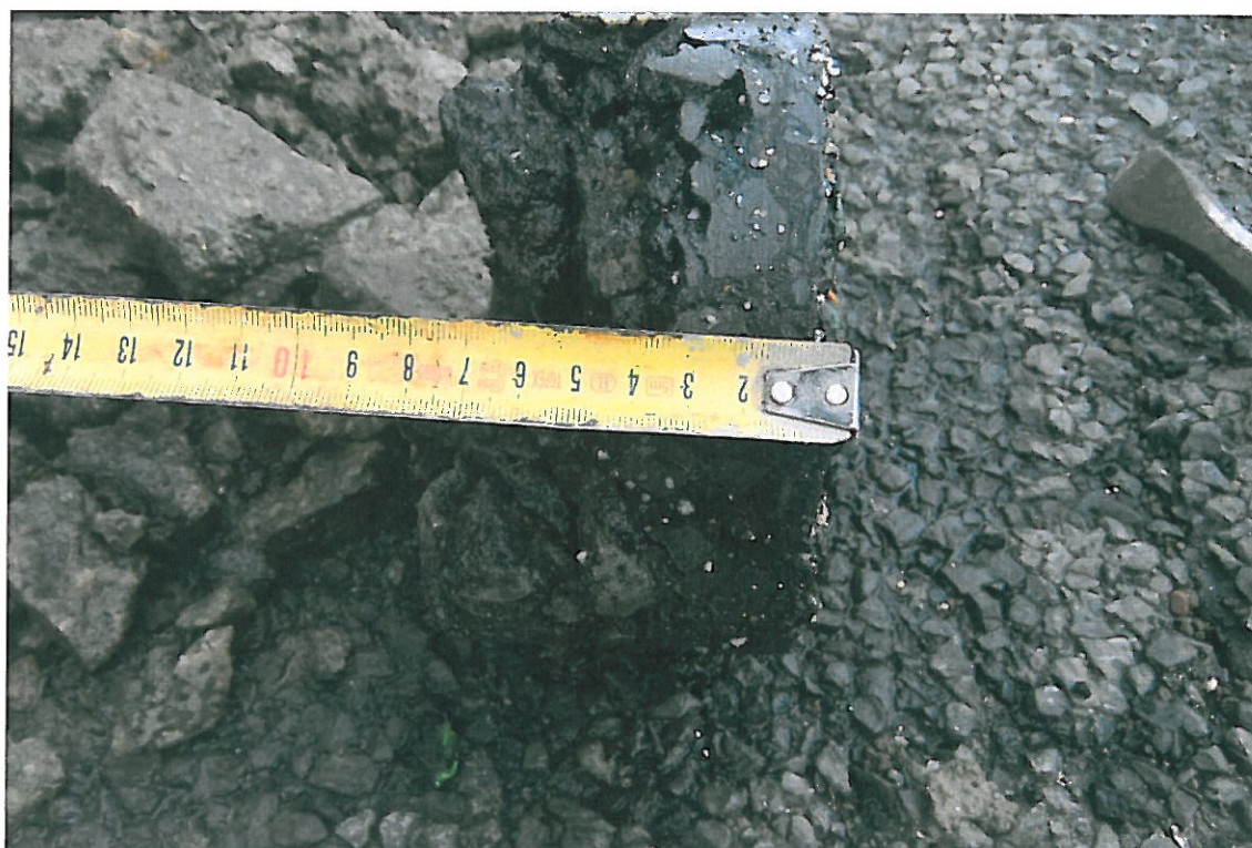
Fot . 109. Widok odwiertu Nr 21 w km 6+000, pas lewy
