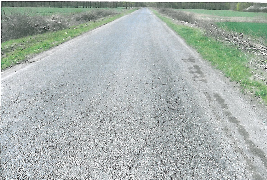
Fot . 91. Widok odcinka drogi Lenartowice - Księginice, km 6+300.
