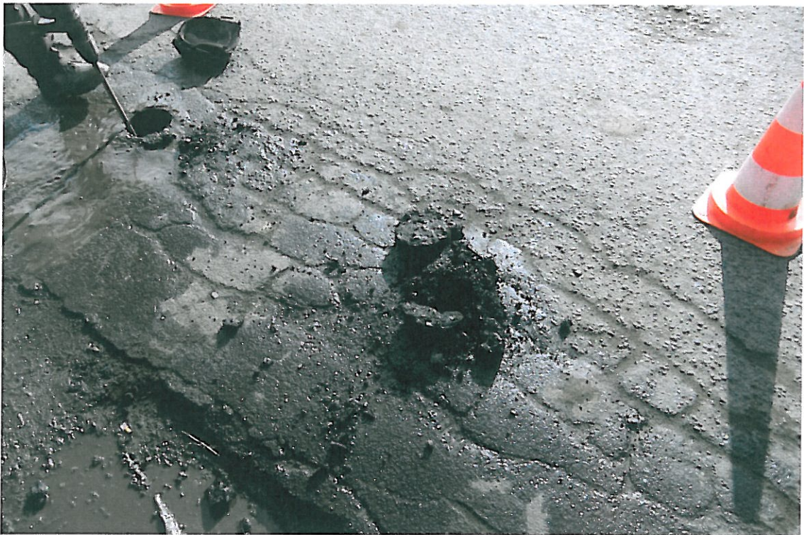
Fot . 8. Widok próbki z warstw bitumicznych odkrywki Nr 1 w km 0+000
