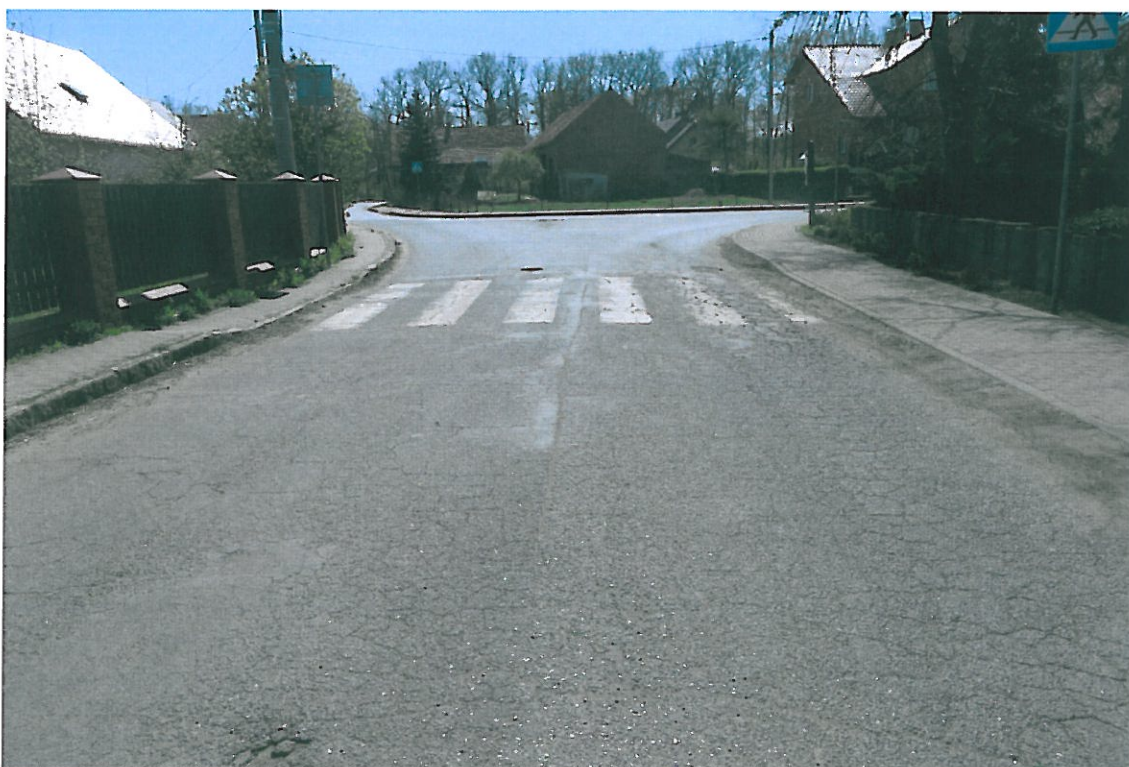
Fot . 123. Widok odcinka drogi Księginice, km 8+250.
