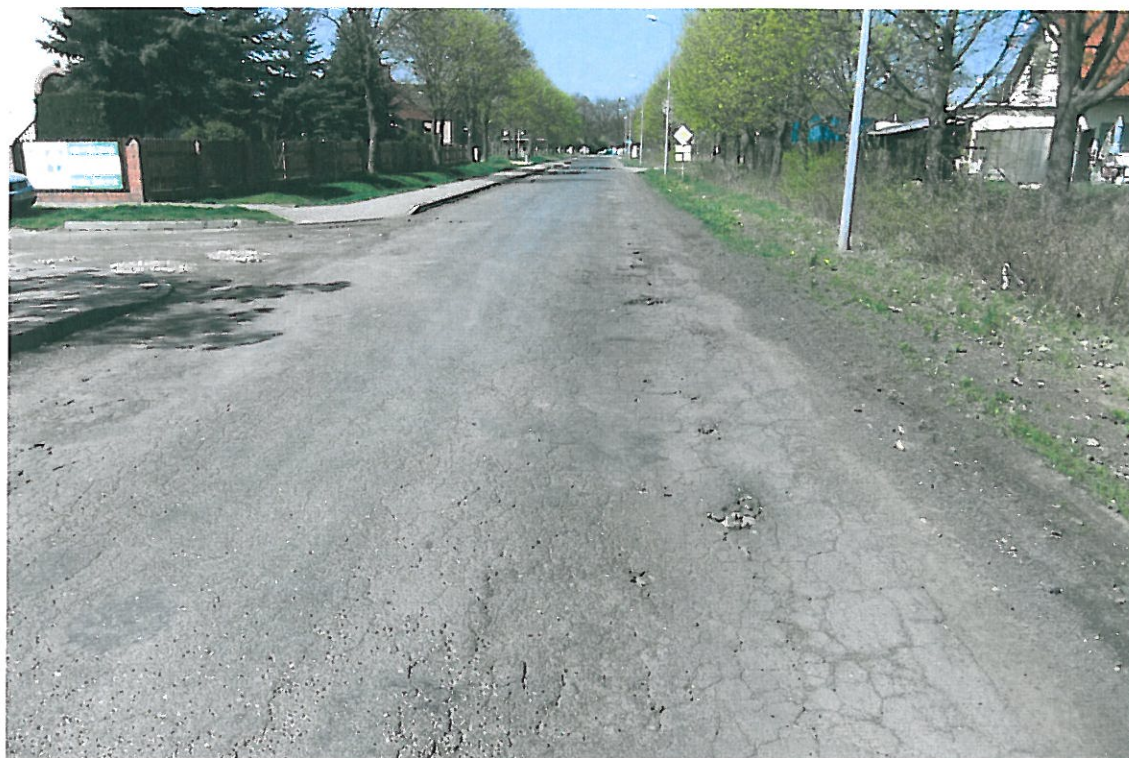
Fot . 119. Widok odcinka drogi Księginice, km 7+500.
