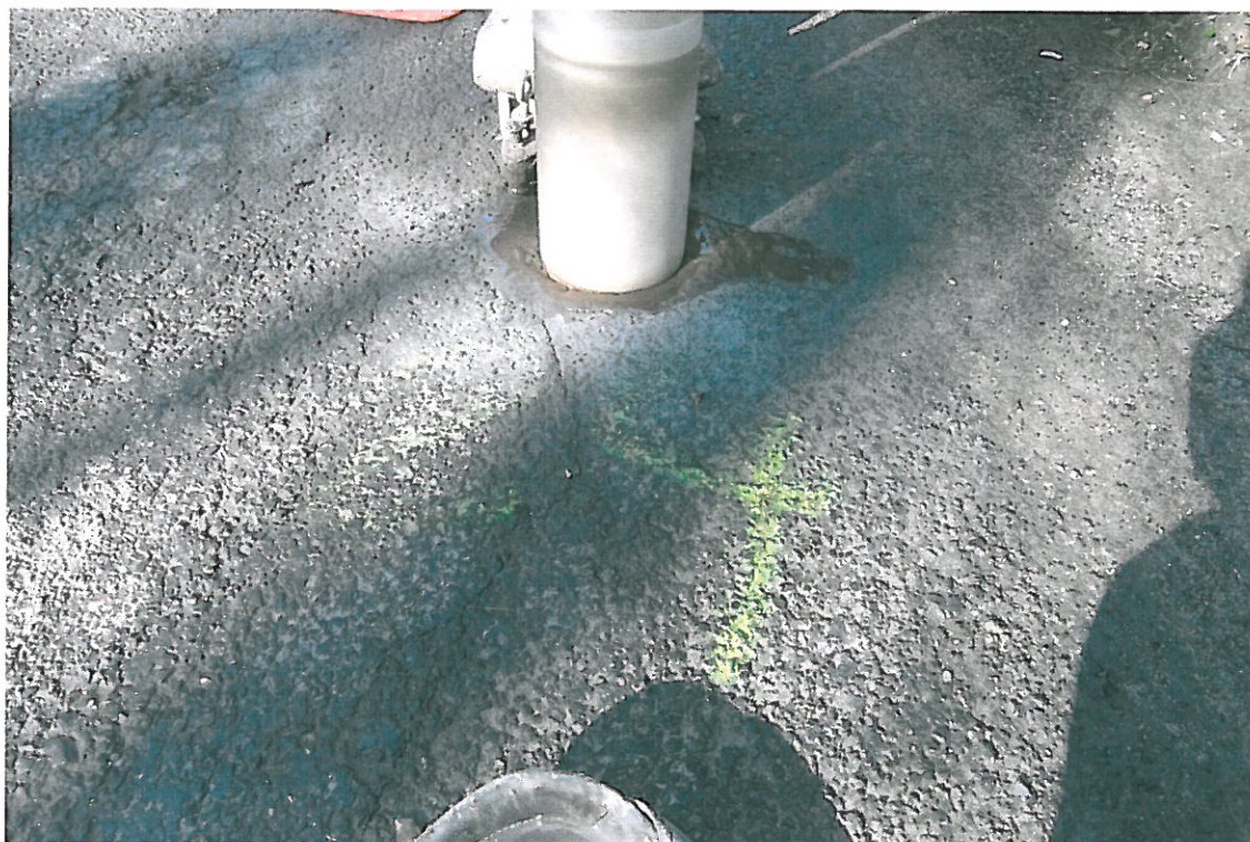
Fot . 124. Lokalizacja odkrywki Nr 24 w km 7+050, pas prawy
