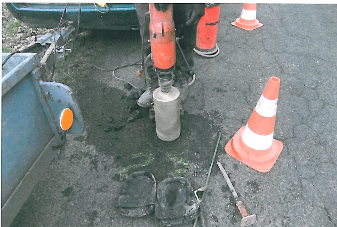
Fot . 115. Widok odwiertu Nr 23 w km 6+700, pas lewy
