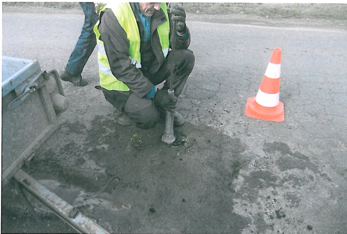
Fot . 15. Widok odkrywki Nr 2 w km 0+360, uzupełnianie odwiertu
