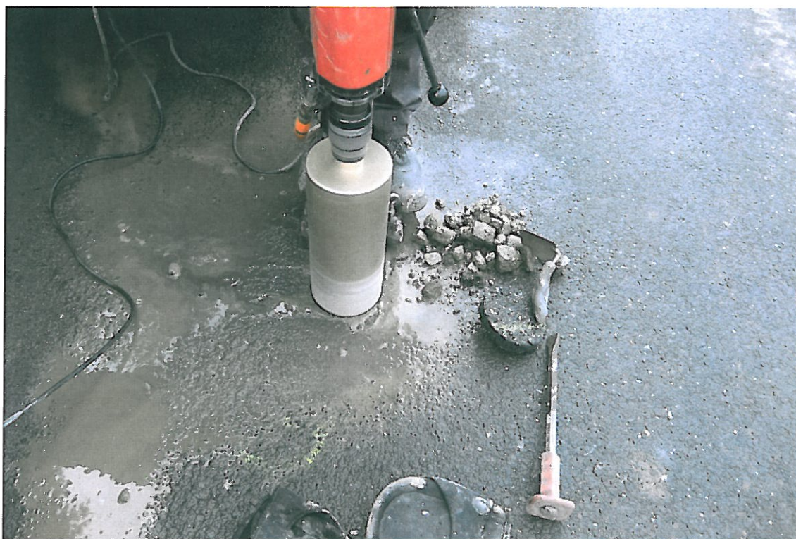
Fot . 103. Widok odwiertu Nr 19 w km 5+300, pas lewy
