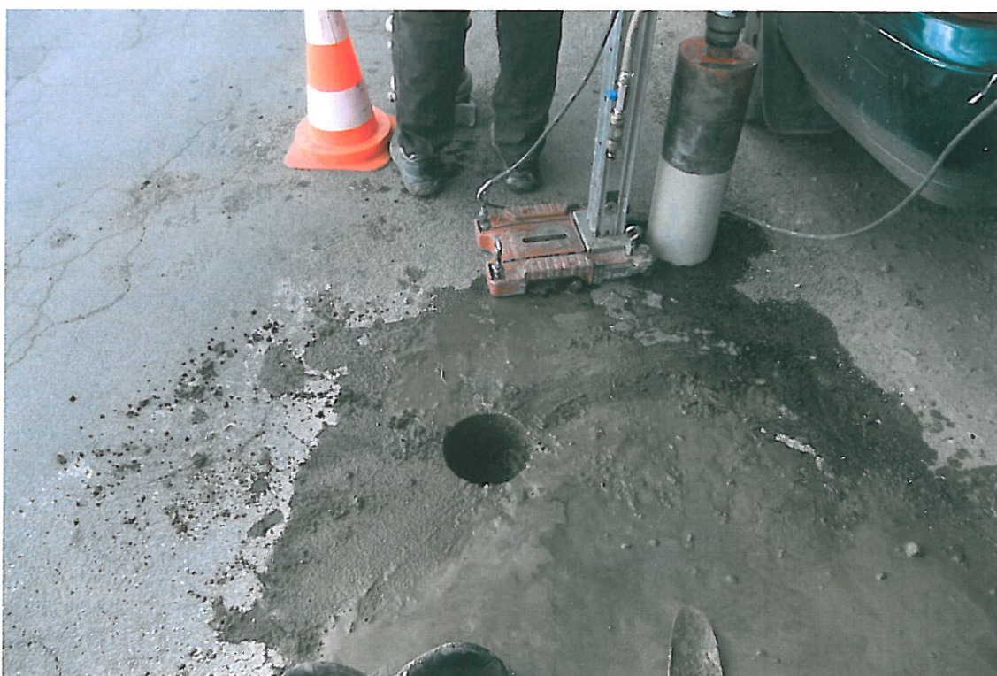
Fot . 46. Widok odkrywki Nr 7 w km 1+000.
