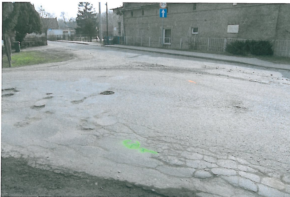
Fot . 1. Widok odcinka drogi w miejscowości Brzezinka Średzka ( km 0+000).
