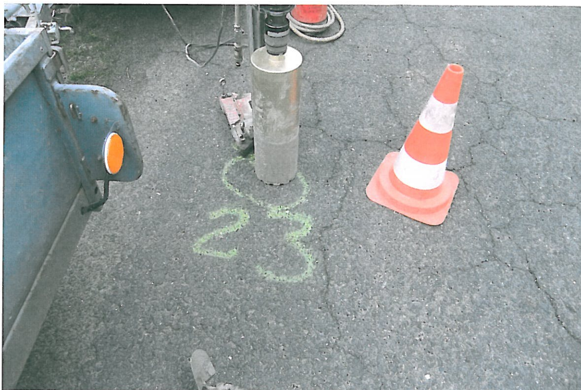
Fot . 114. Lokalizacja odkrywki Nr 23 w km 6+700, pas lewy
