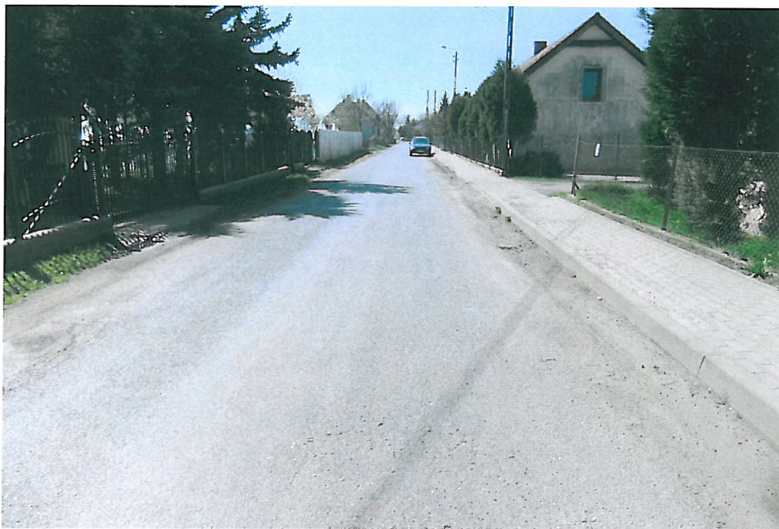
Fot . 86. Widok odcinka drogi – Lenartowice - Księginice, km 5+300.
