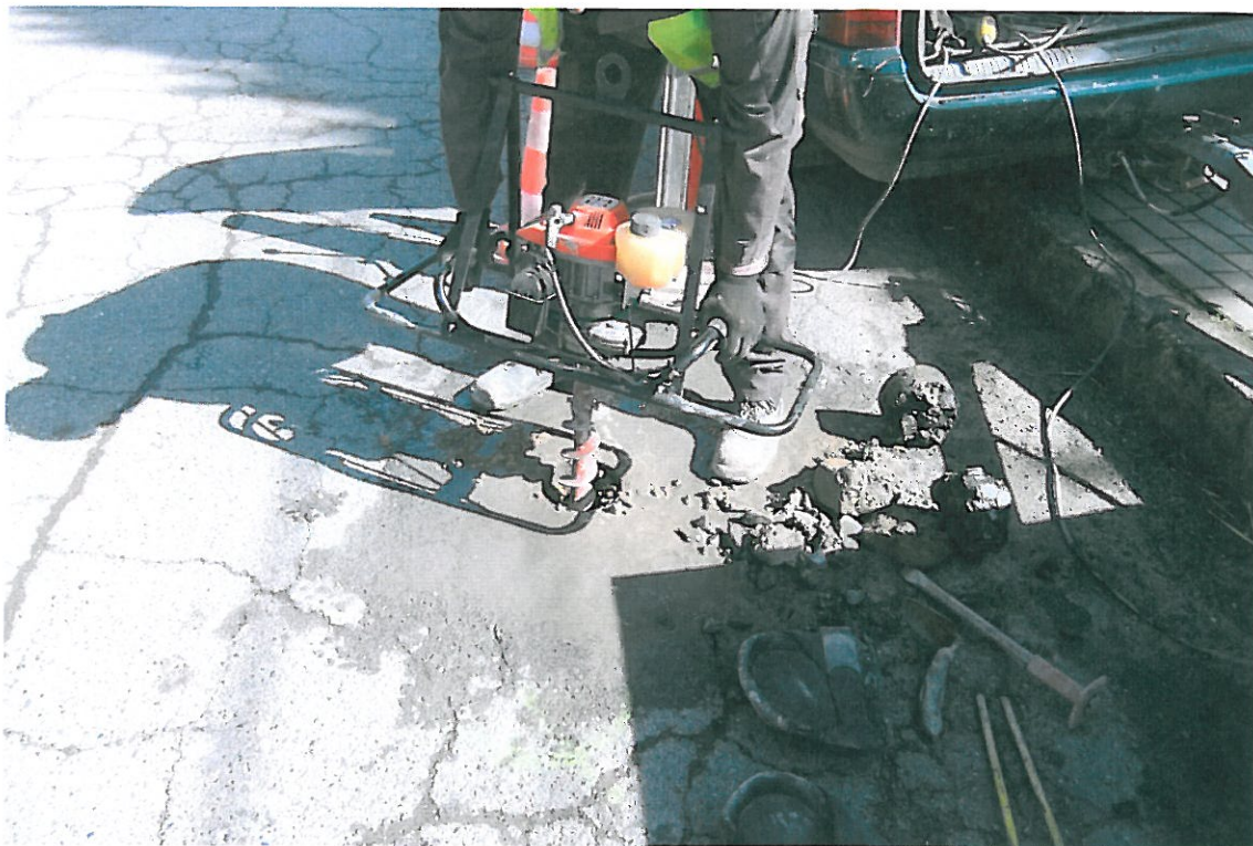
Fot . 137. Pobieranie próbki kruszywa z podsypki, odwiertu Nr 27 w km 8+085, pas prawy
