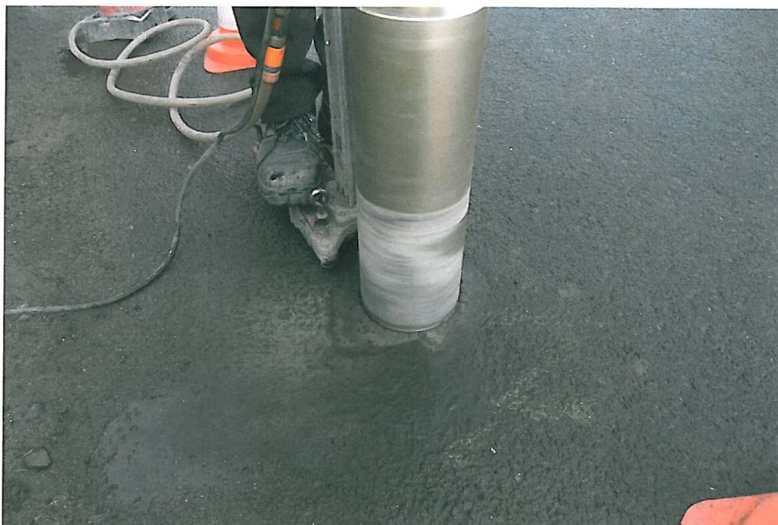
Fot . 96. Pobieranie odwiertu Nr 17 w km 4+700, pas lewy
