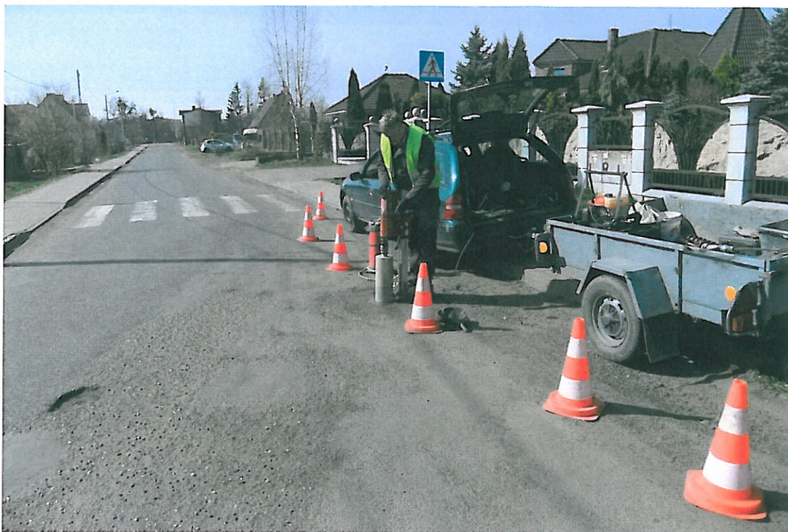
Fot . 130. Lokalizacja odkrywki Nr 26 w km 7+740, pas prawy
