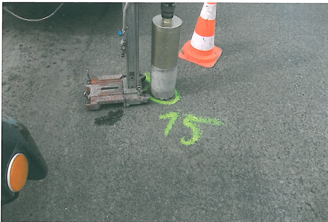
Fot . 79. Lokalizacja odkrywki Nr 15 w km 3+900, pas lewy
