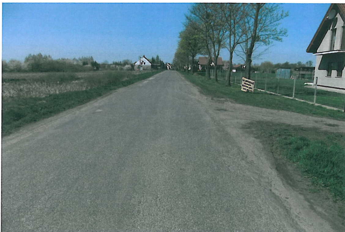
Fot . 67. Widok odcinka drogi Prężyce - Lenartowice, km 4+400.
