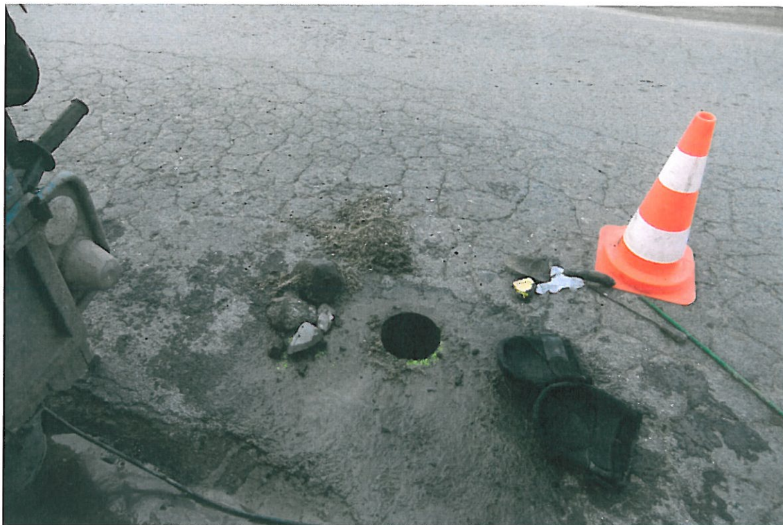
Fot . 13. Widok odwiertu z bruku kamiennego odkrywka Nr 2 w km 0+360,
