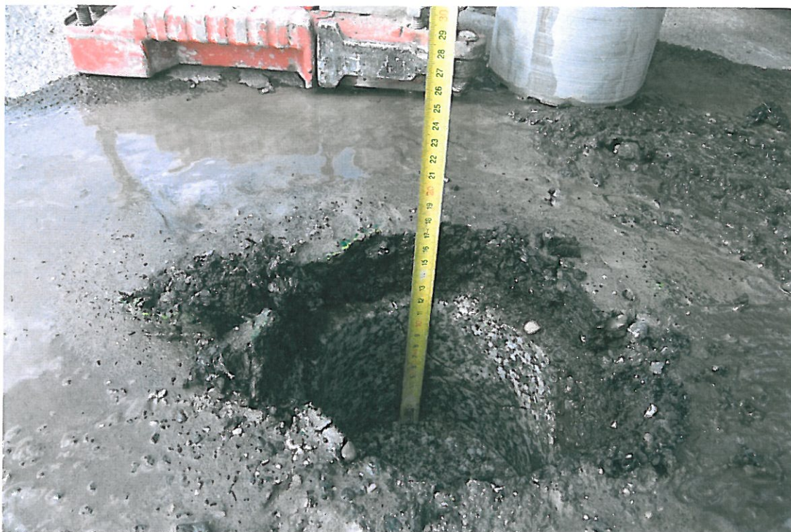
Fot . 76. Widok odwiertu Nr 13 w km 3+200, pas lewy
