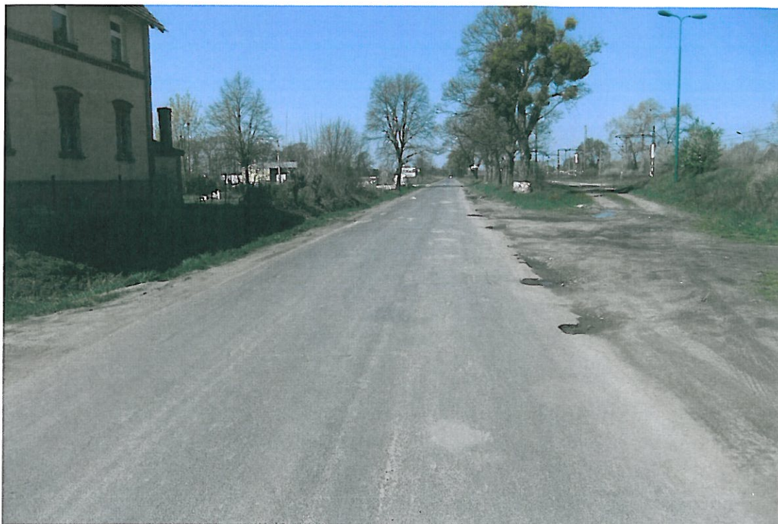
Fot . 20. Widok odcinka drogi Gosławice - Prężyce, km 0+200.
