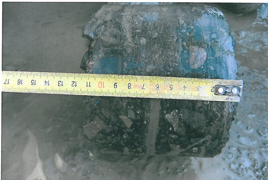
Fot . 101. Widok odwiertu Nr 18 w km 5+000, pas prawy
