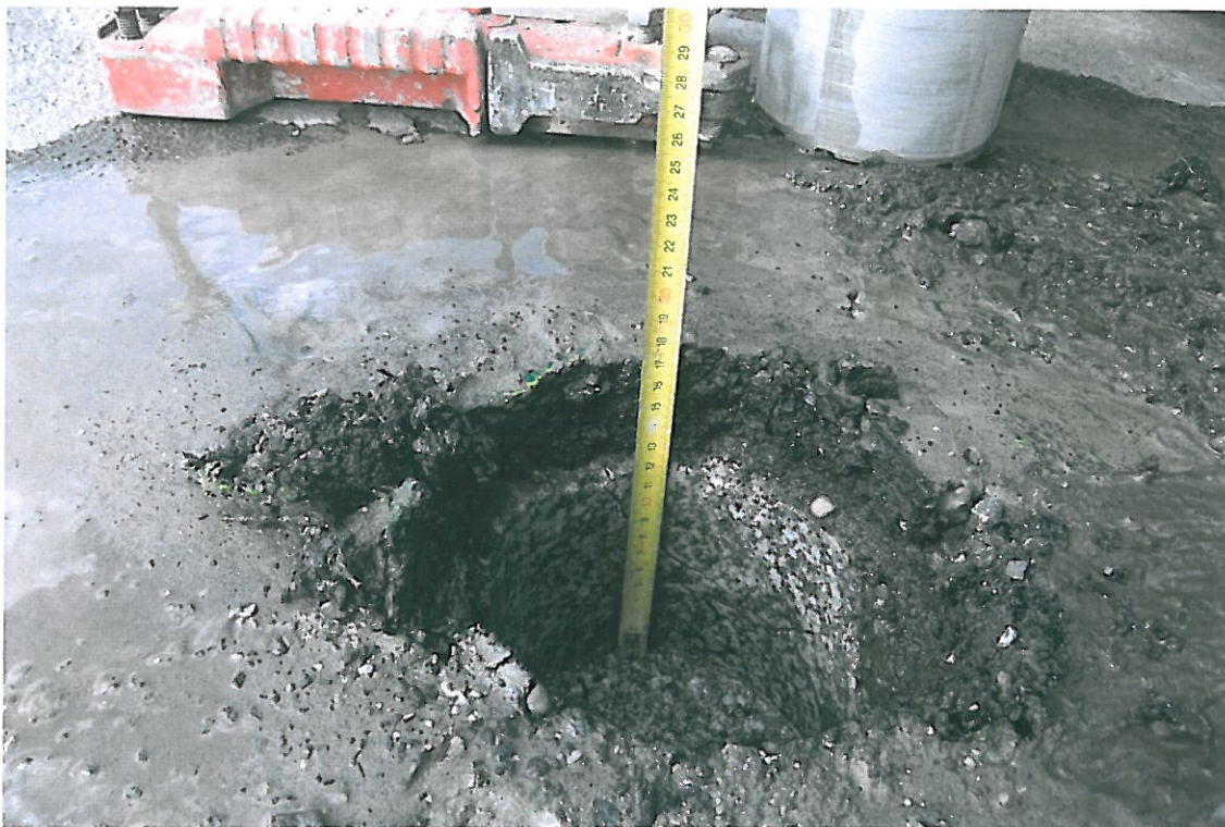
Fot . 39. Widok odwiertu Nr 5 w km 0+400.
