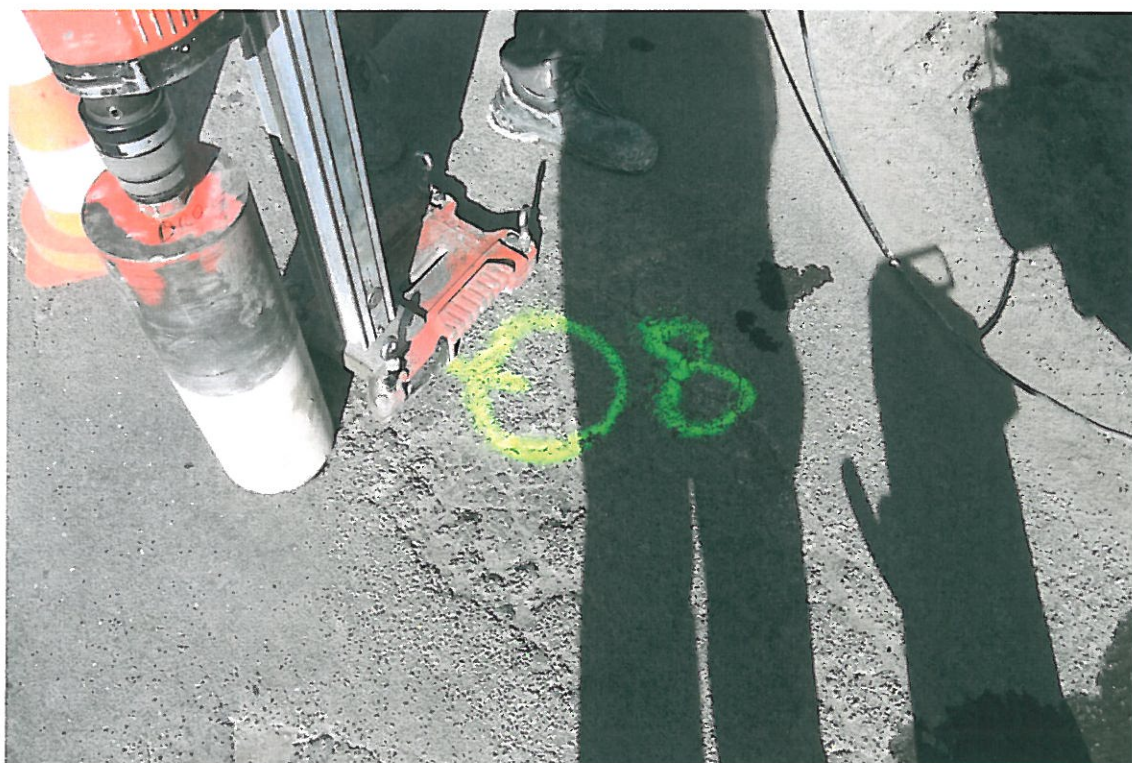
Fot . 47. Lokalizacja odkrywki Nr 8 w km 1+370, pas prawy
