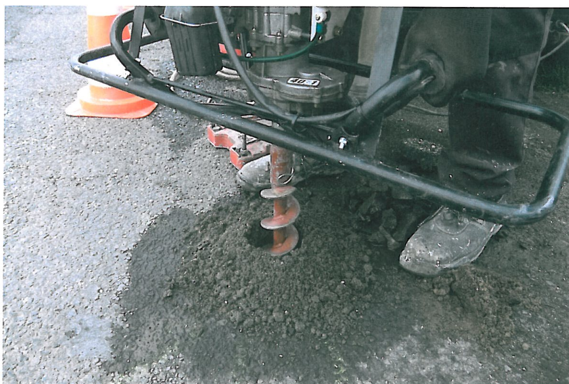
Fot . 106. Widok próbki z podbudowy odwiertu Nr 20, w km 5+650, pas prawy
