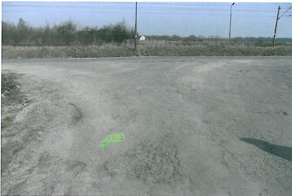
Fot . 5. . Widok odcinka drogi Brzezinka Średzka – Księginice, km 0+750.
