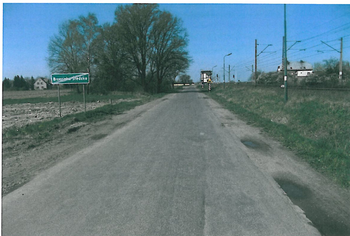
Fot . 23. Widok odcinka drogi Gostawice – Prężyce, km 0+800.
