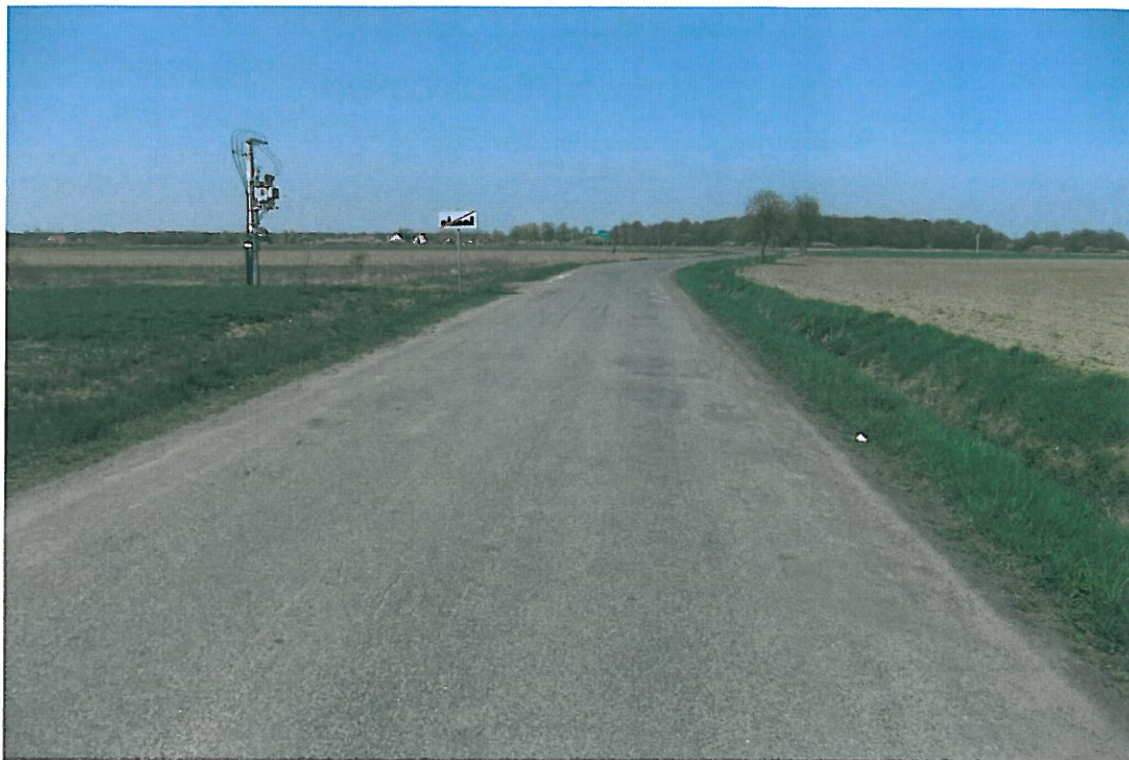
Fot . 64. Widok odcinka drogi Prężyce - Lenartowice, km 3+800.
