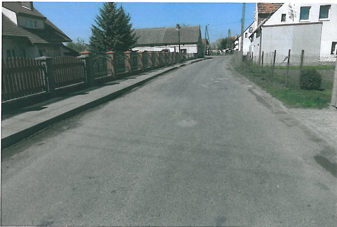
Fot . 85. Widok odcinka drogi Lenartowice - Księginice, km 5+100.
