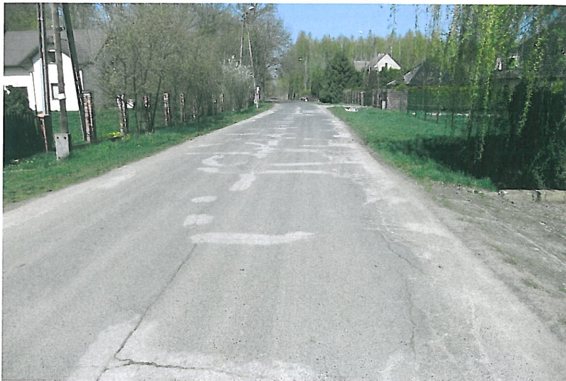
Fot . 58. Widok odcinka drogi Prężyce - Lenartowice, km 2+600.
