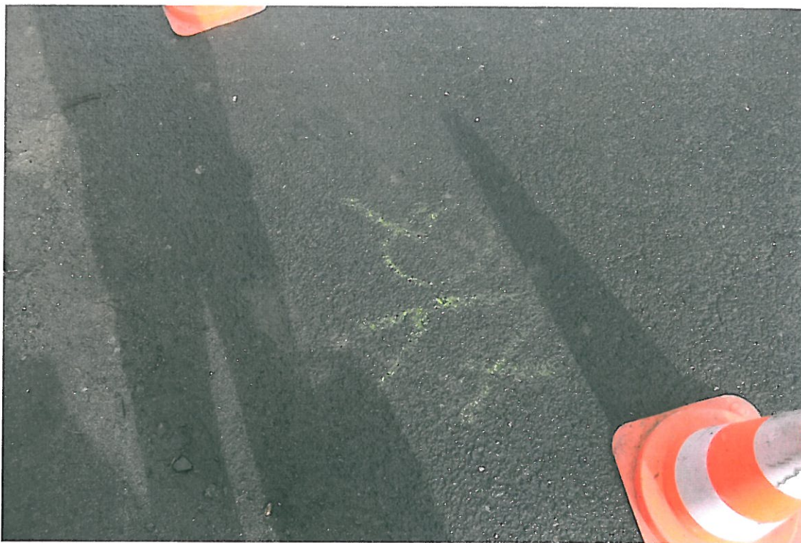
Fot . 95. Lokalizacja odkrywki Nr 17 w km 4+700, pas lewy
