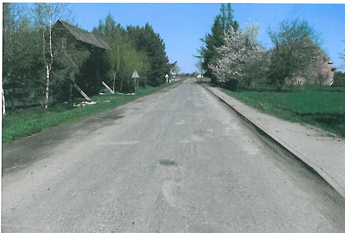
Fot . 25. Widok odcinka drogi Gosławice – Prężyce, km 1+200.
