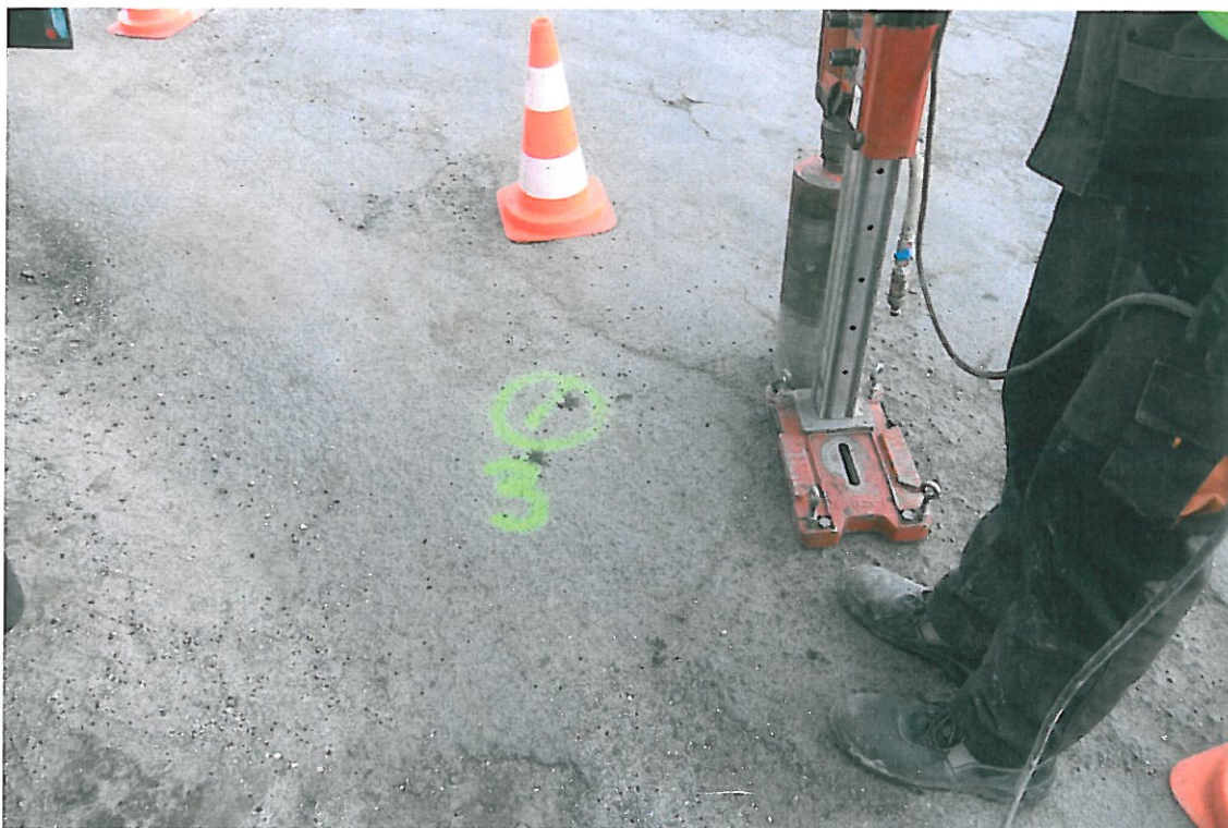
Fot . 16. Lokalizacja odkrywki Nr 3 w km 0+750 pas lewy
