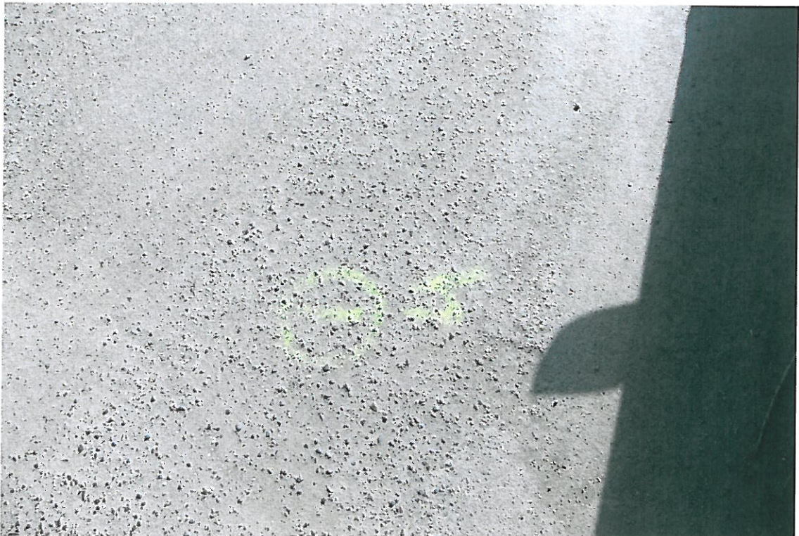
Fot . 31. Lokalizacja odkrywki Nr 4 w km 0+000, pas lewy
