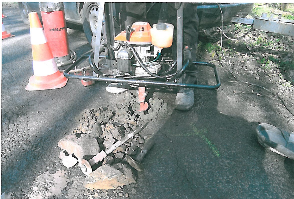
Fot . 126. Pobieranie próbki kruszywa z podsypki, odwiertu Nr 24 w km 7+050, pas prawy
