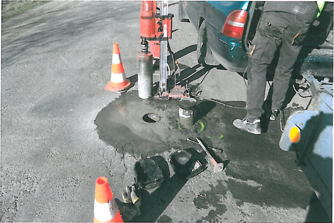
Fot . 50. Widok odkrywki Nr 8 w km 1+370, pobieranie próbki z podsypki
