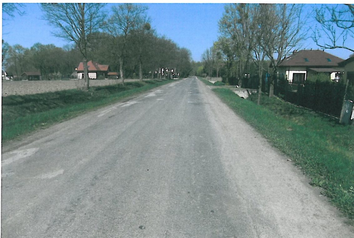
Fot . 57. Widok odcinka drogi Prężyce - Lenartowice ( km 2+400 ).
