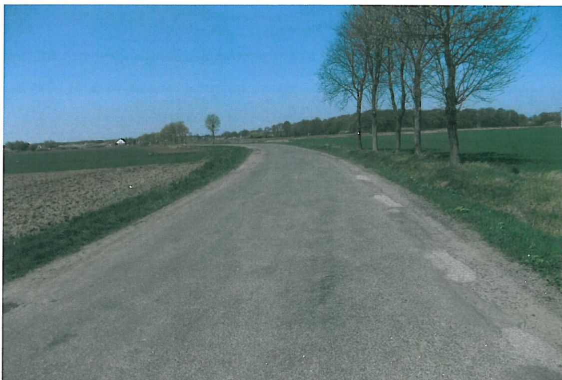
Fot . 65. Widok odcinka drogi Prężyce - Lenartowice, km 4+000.
