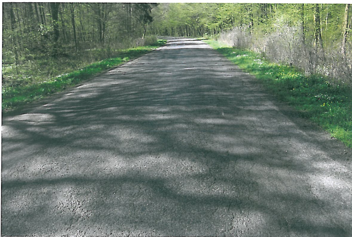
Fot . 93. Widok odcinka drogi Lenartowice Księginice, km 6+700.
