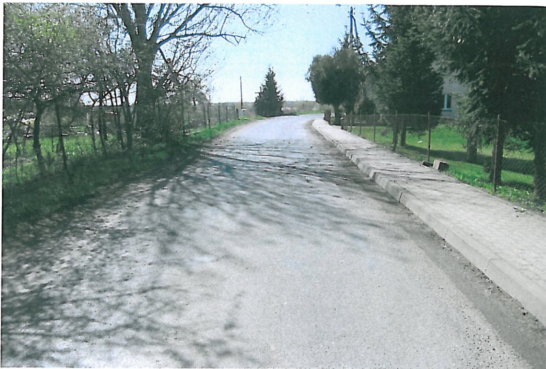
Fot . 87 . Widok odcinka drogi Lenartowice - Księginice, km 5+500.
