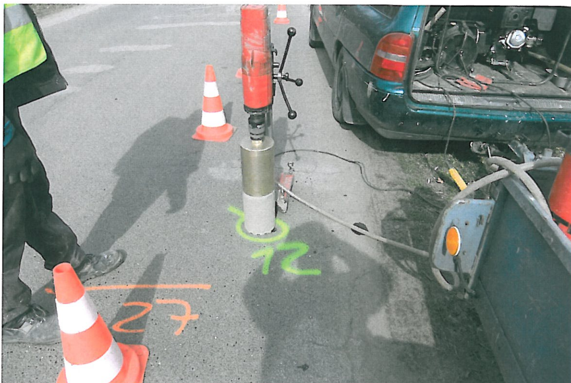
Fot . 73. Lokalizacja odkrywki Nr 12 w km 2+700, pas prawy
