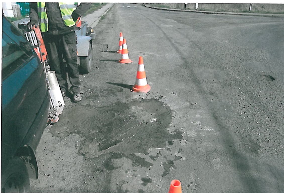
Fot . 138. Pobieranie próbki kruszywa z podsypki, odwiertu Nr 26 w km 7+740, pas prawy
