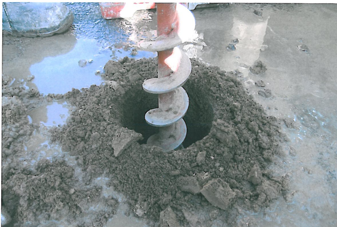
Fot . 13. Pobieranie próbki z podbudowy odkrywka Nr 18 w km 5+000,
