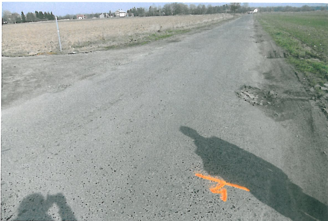
Fot . 3. Widok odcinka drogi Brzezinka Średzka – Gosławice, km 0+400.
