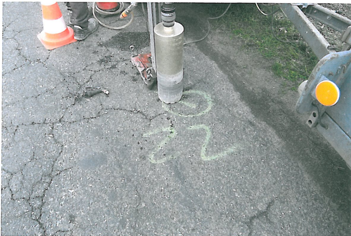
Fot . 111. Lokalizacja odkrywki Nr 22 w km 6+360, pas prawy
