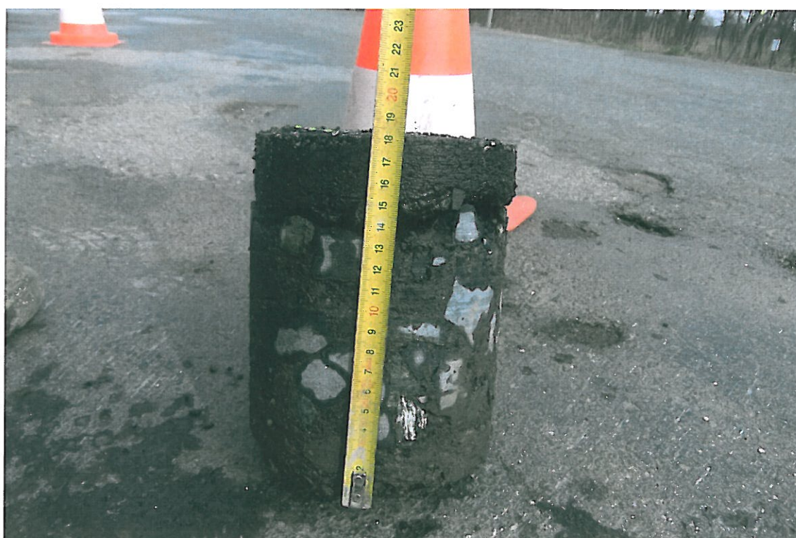
Fot . 71. Widok próbki z warstw bitumicznych odkrywki Nr 11 w km 2+400
