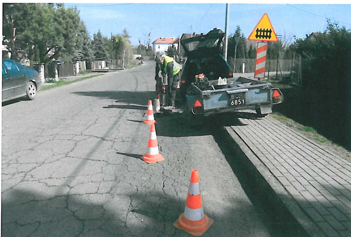
Fot . 134. Lokalizacja odkrywki Nr 27 w km 8+085, pas prawy
