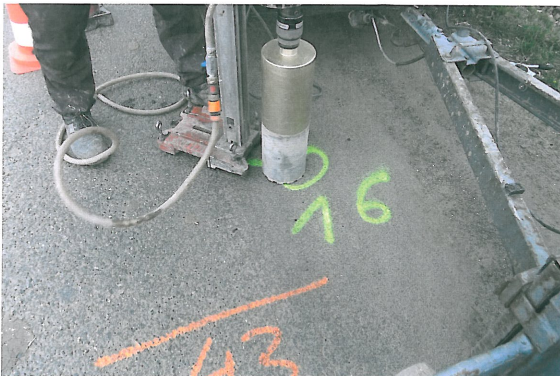
Fot . 81. Lokalizacja odkrywki Nr 16 w km 4+300, pas prawy
