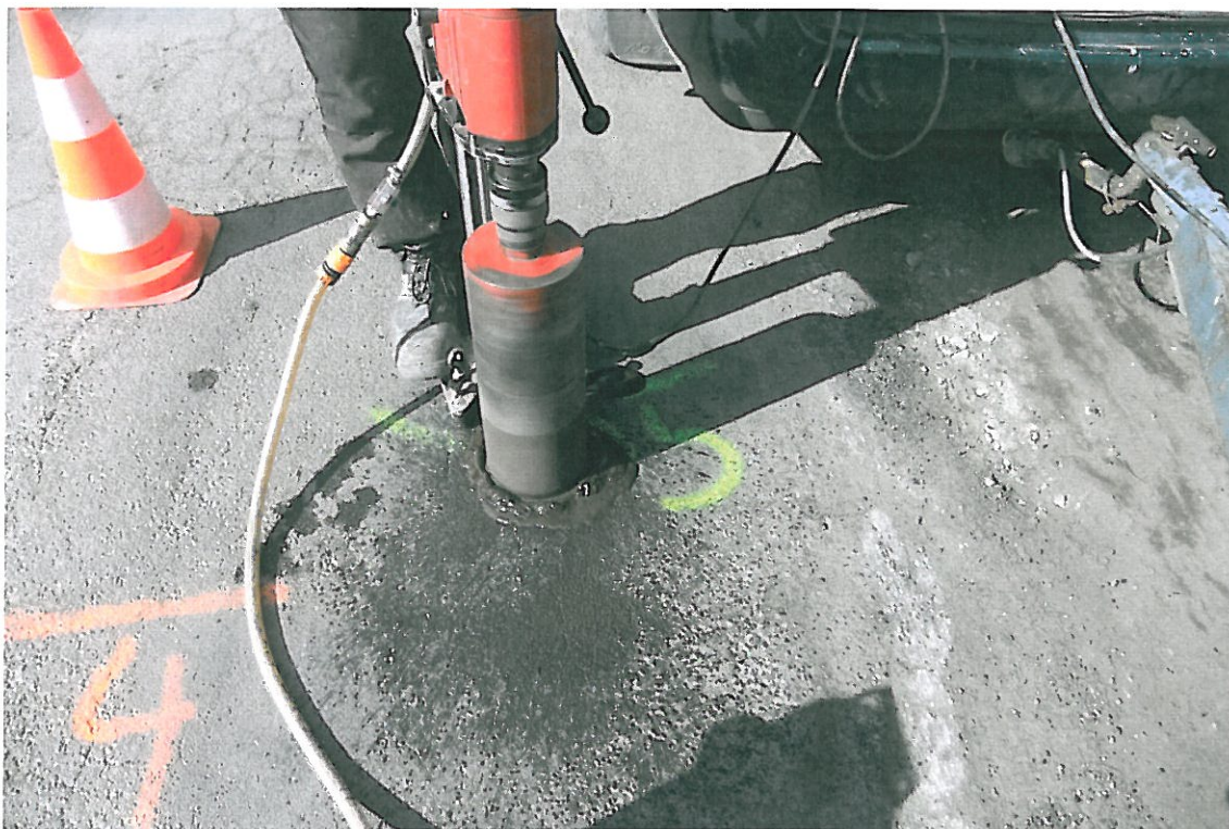
Fot . 37. Pobieranie odwiertu Nr 5 w km 0+400, pas prawy
