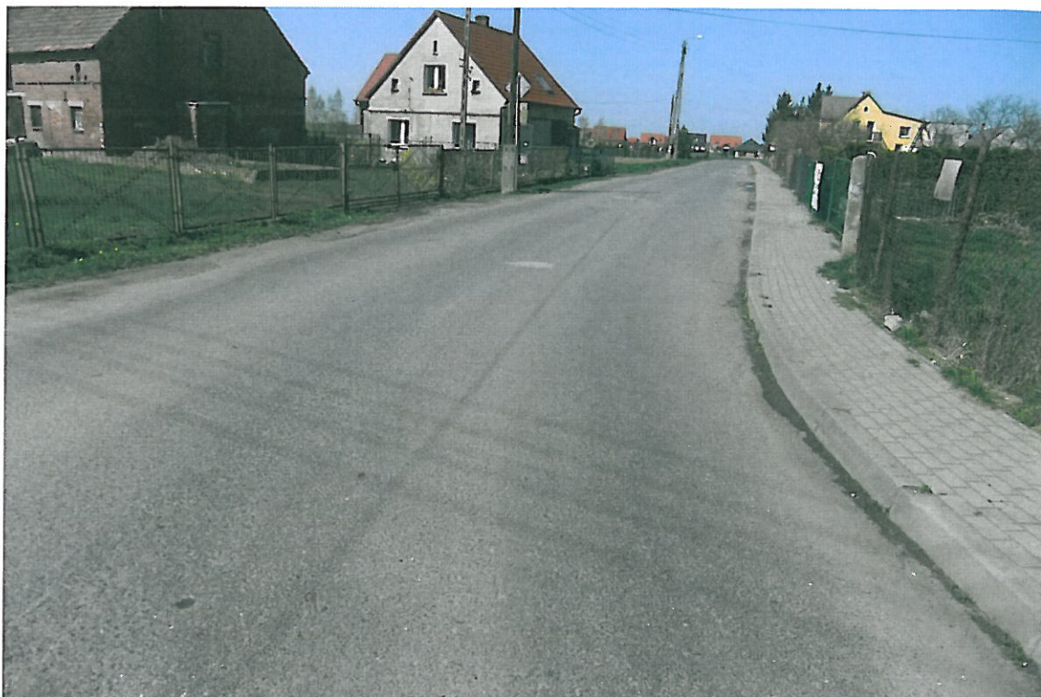
Fot . 62. Widok odcinka drogi Prężyce - Lenartowice, km 3+400.
