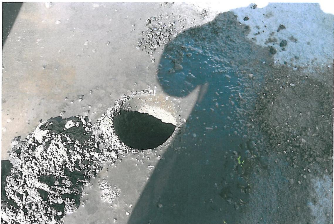
Fot . 35. Widok odwiertu Nr 4 w km 0+000.
