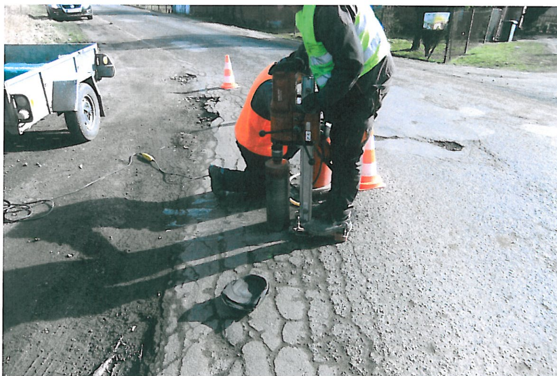
Fot . 7. Widok odwiertu Nr 1 w km 0+00, pas lewy
