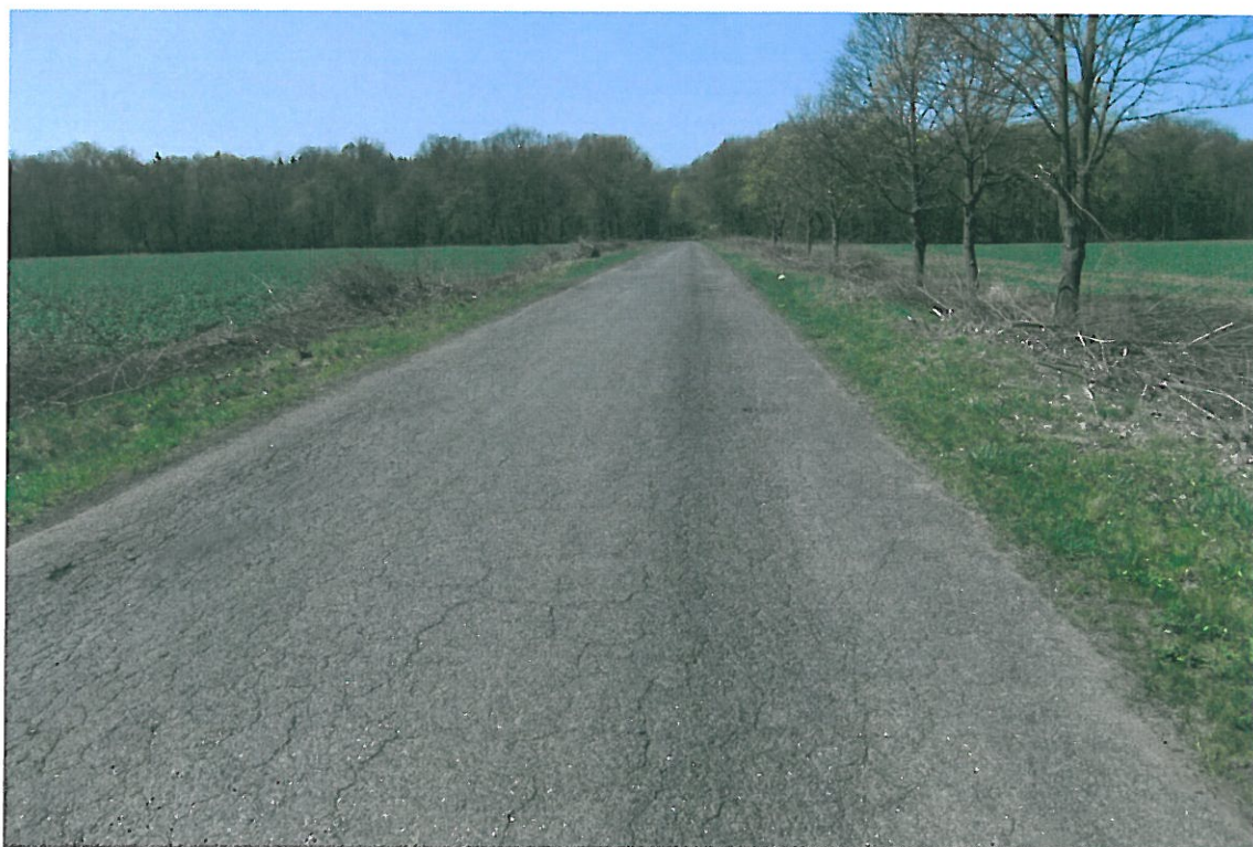
Fot . 92. Widok odcinka drogi Lenartowice - Księginice, km 6+500.
