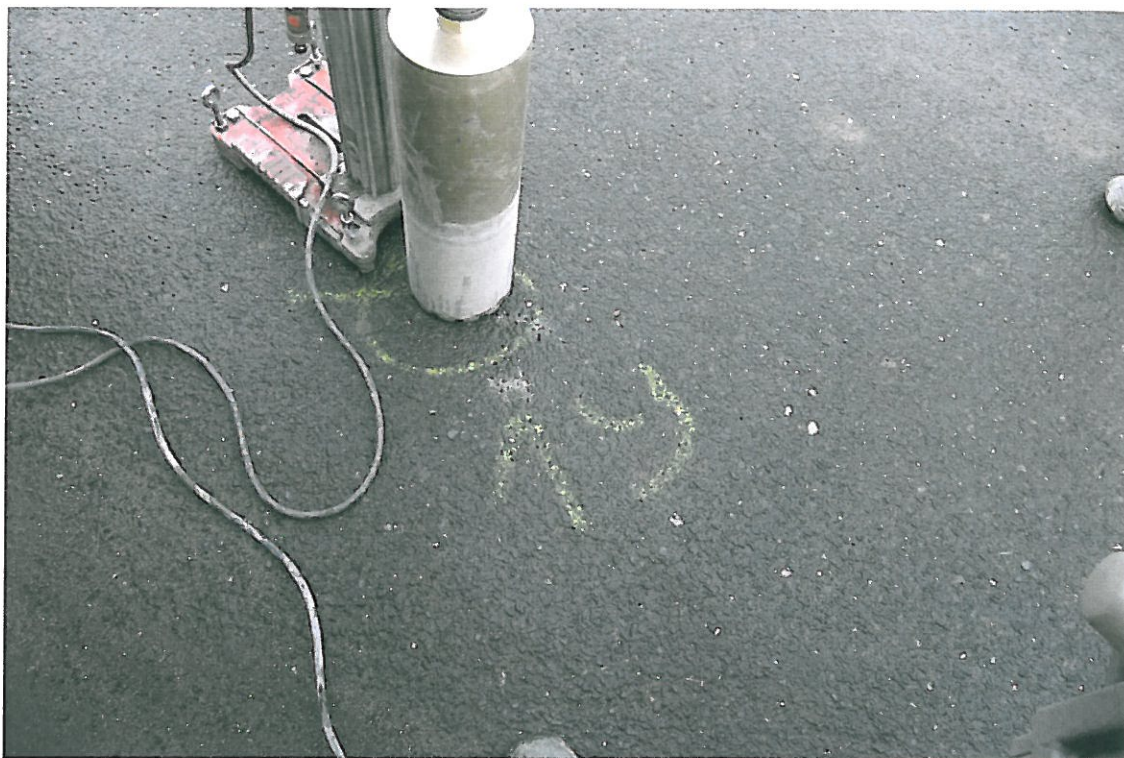
Fot . 102. Lokalizacja odkrywki Nr 19 w km 5+300 pas lewy
