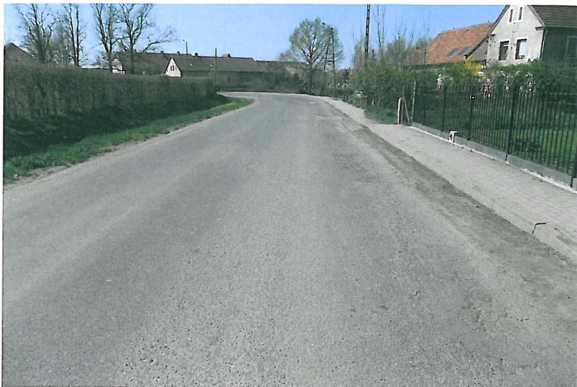
Fot . 60. Widok odcinka drogi Prężyce - Lenartowice km 3+000.
