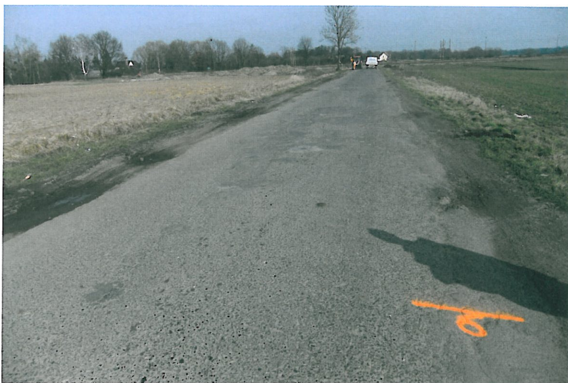
Fot . 4. . Widok odcinka drogi Brzezinka Średzka – Gosławice, km 0+600.
