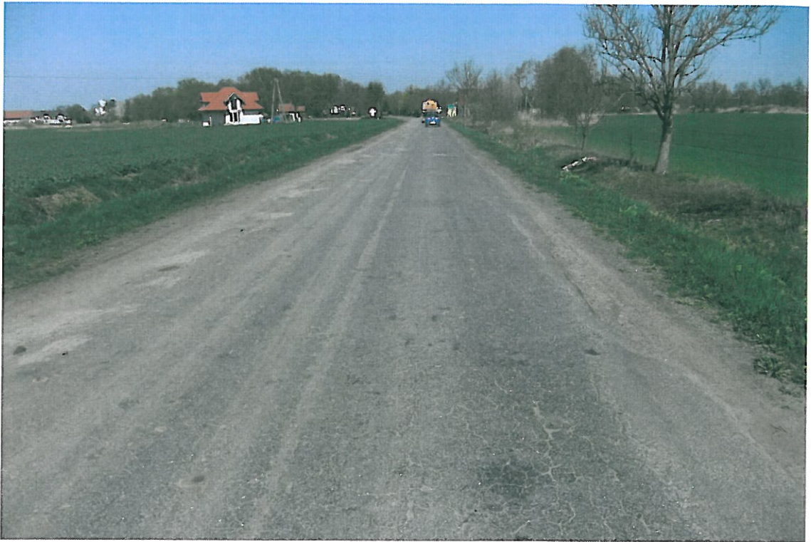
Fot . 30. Widok odcinka drogi Gosławice – Prężyce, km 2+200.
