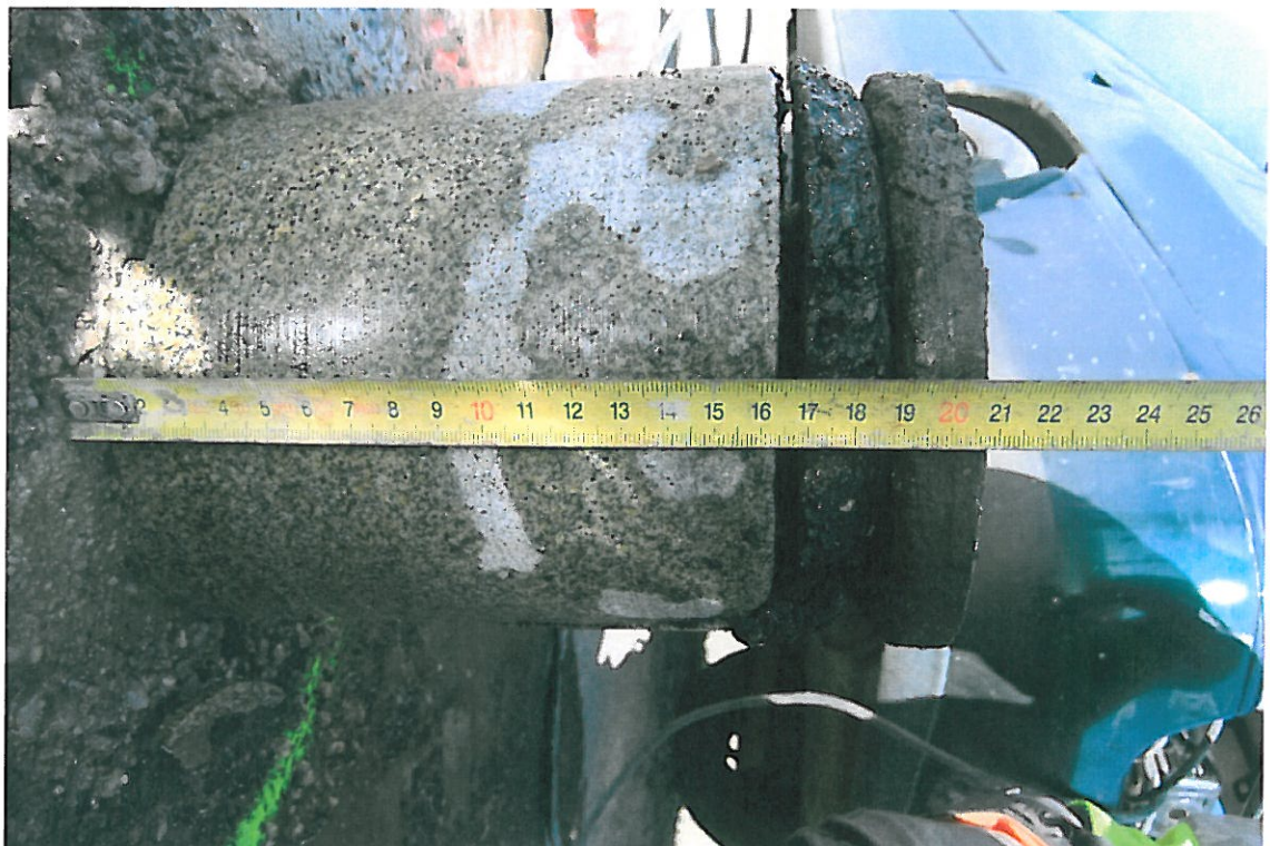
Fot . 49. Widok odwiertu z bruku kamiennego odkrywka Nr 8 w km 1+370,
