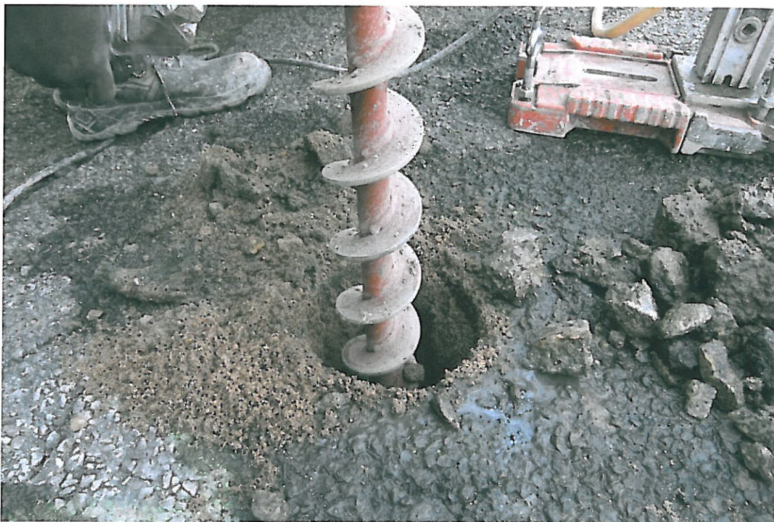
Fot . 110. Widok kruszywa z odkrywki Nr 21, w km 6+000,
