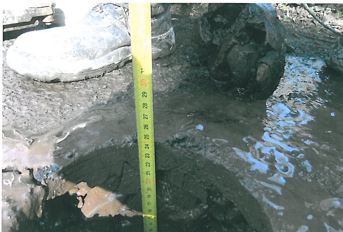
Fot . 125. Widok próbki kruszywa z podbudowy, odwiertu Nr 24 w km 7+050, pas prawy
