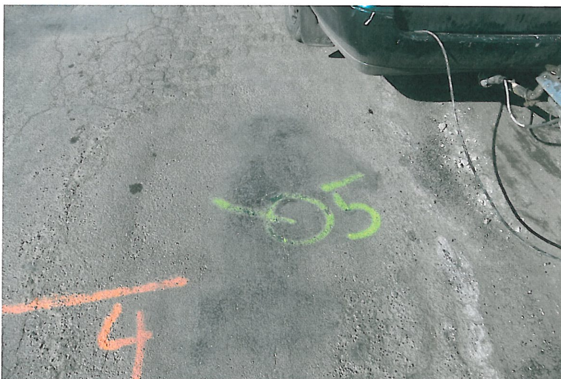
Fot . 36. Lokalizacja odkrywki Nr 5 w km 0+400, pas prawy
