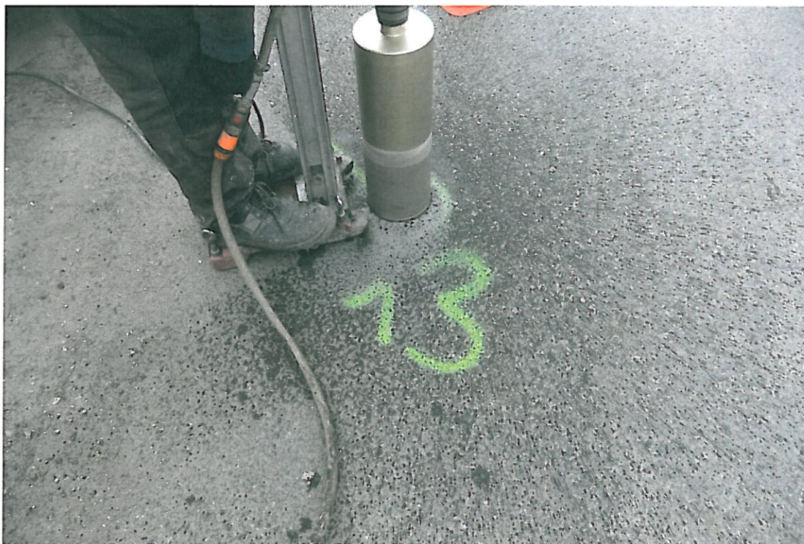
Fot . 75. Lokalizacja odkrywki Nr 13 w km 3+200 pas lewy
