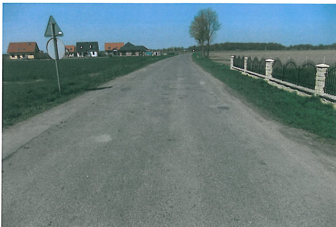
Fot . 63. Widok odcinka drogi Prężyce - Lenartowice, km 3+600.
