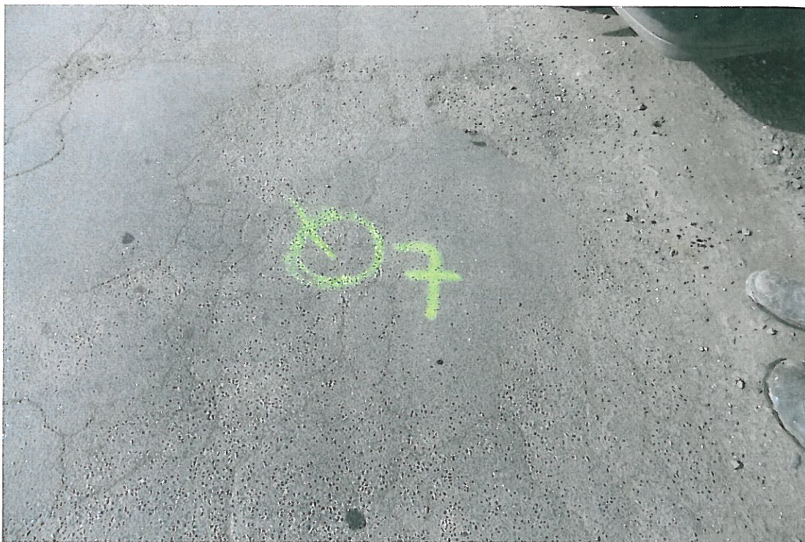
Fot . 43. Lokalizacja odkrywki Nr 7 w km 1+000, pas lewy
