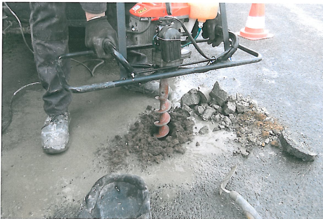
Fot . 104. Widok odwiertu Nr 19 w km 5+300, pas lewy
