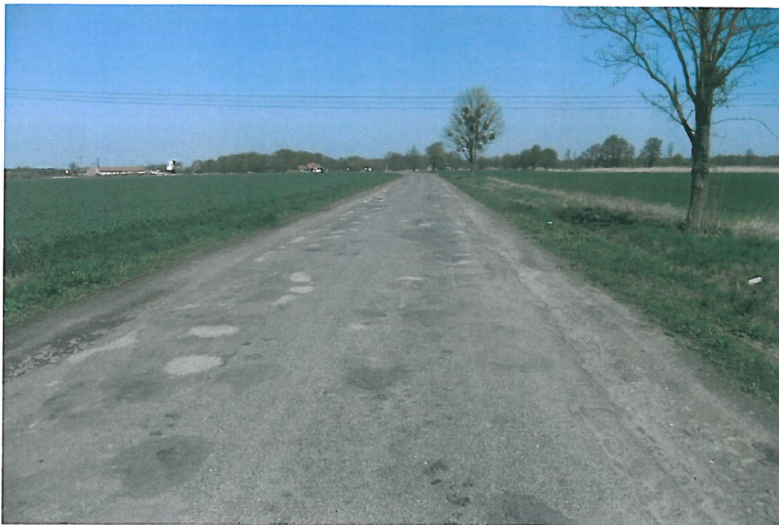
Fot . 28. Widok odcinka drogi Gosławice – Prężyce, km 1+800.
