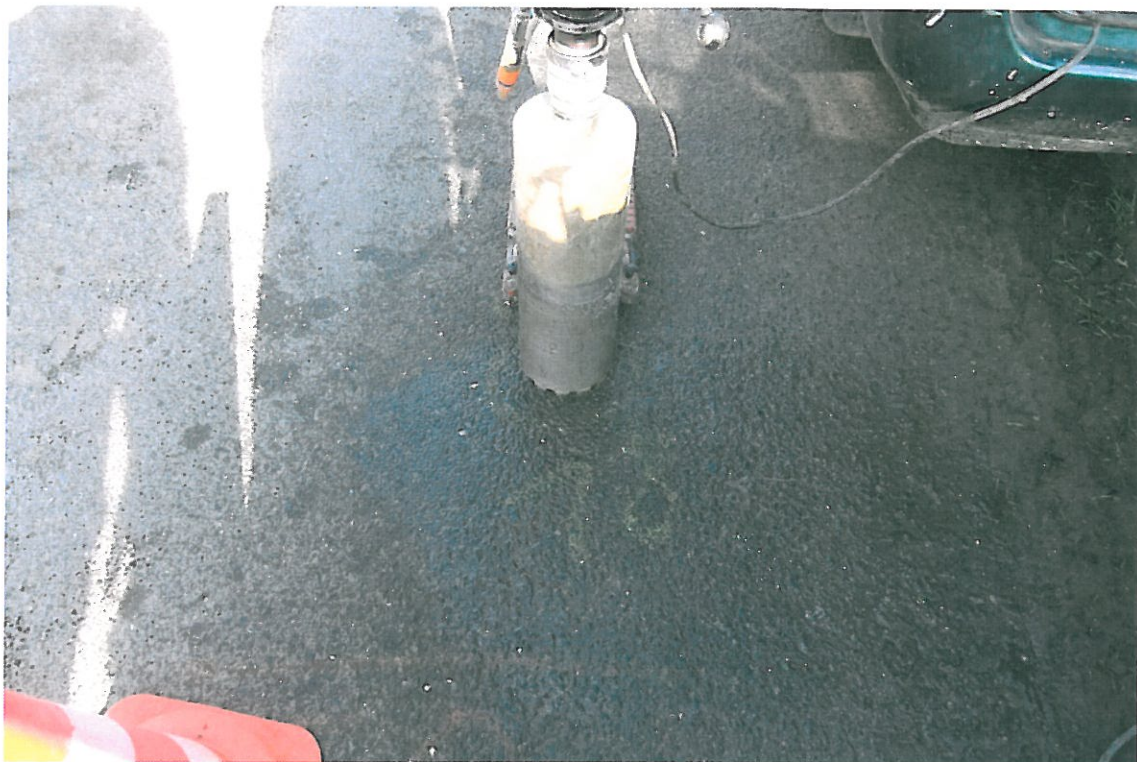
Fot . 100. Lokalizacja odkrywki Nr 18 w km 5+000, pas prawy
