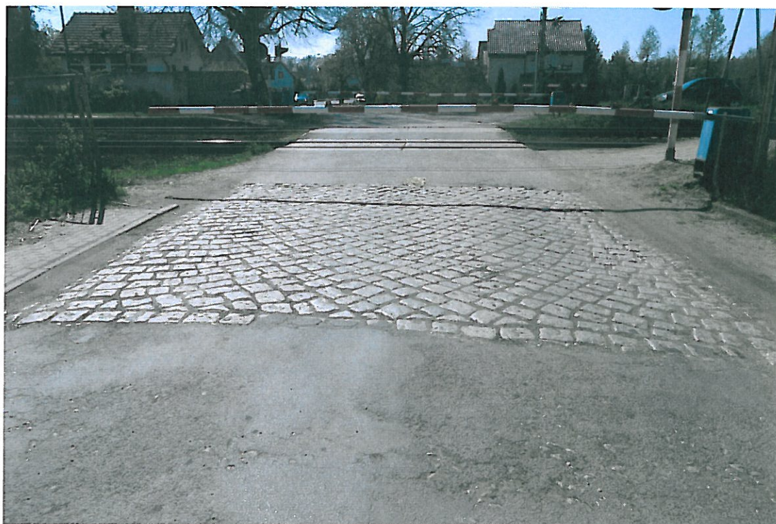
Fot . 121. Widok odcinka Księginice, km 7+900.
