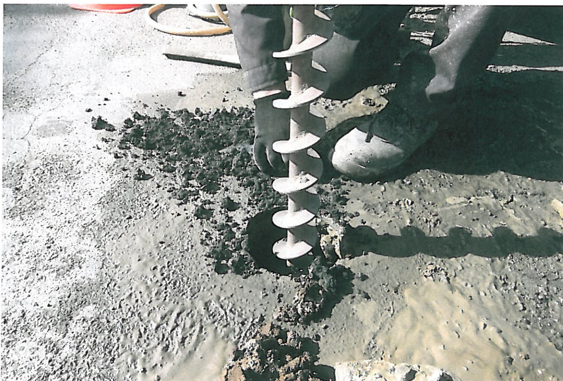
Fot . 133. Pobieranie próbki kruszywa z podsypki, odwiertu Nr 26 w km 7+740, pas prawy
