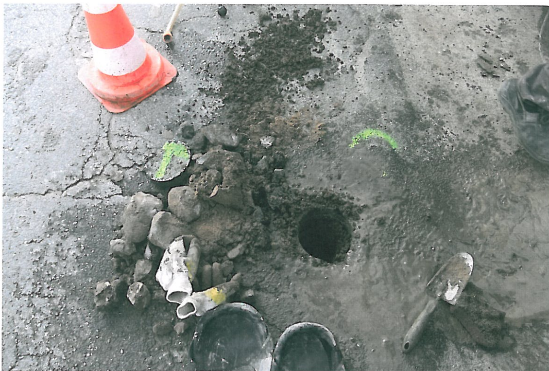
Fot . 53. Widok kruszywa z podbudowy i podsypki odkrywki Nr 9 w km 1+700,
