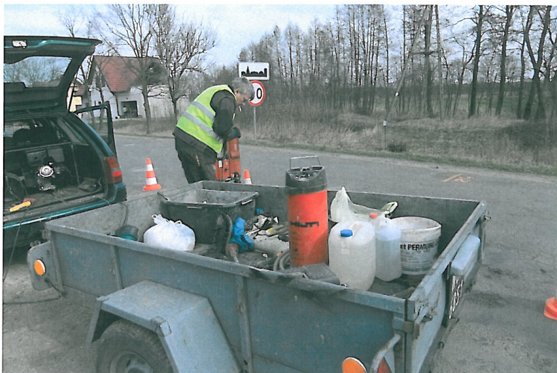
Fot . 70. Pobieranie odwiertu Nr 11 w km 2+400, pas lewy
