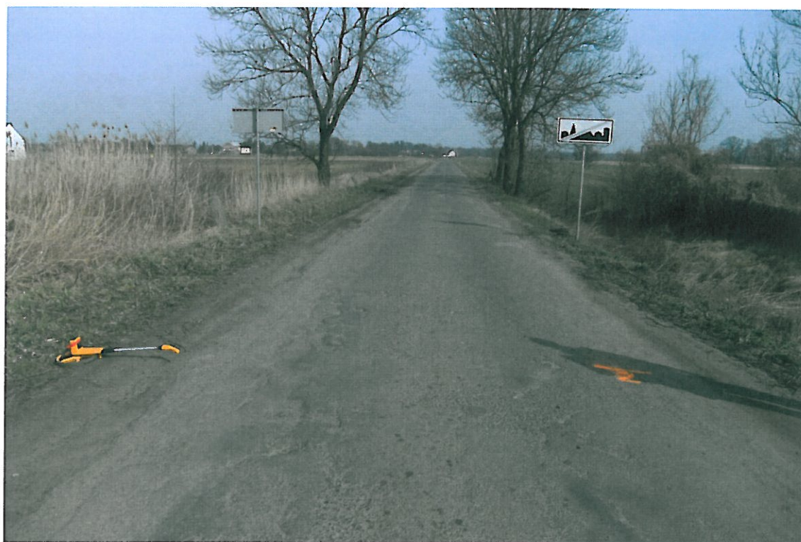
Fot . 2. Widok odcinka drogi Brzezinka Średzka – Gostawice, km 0+200.
