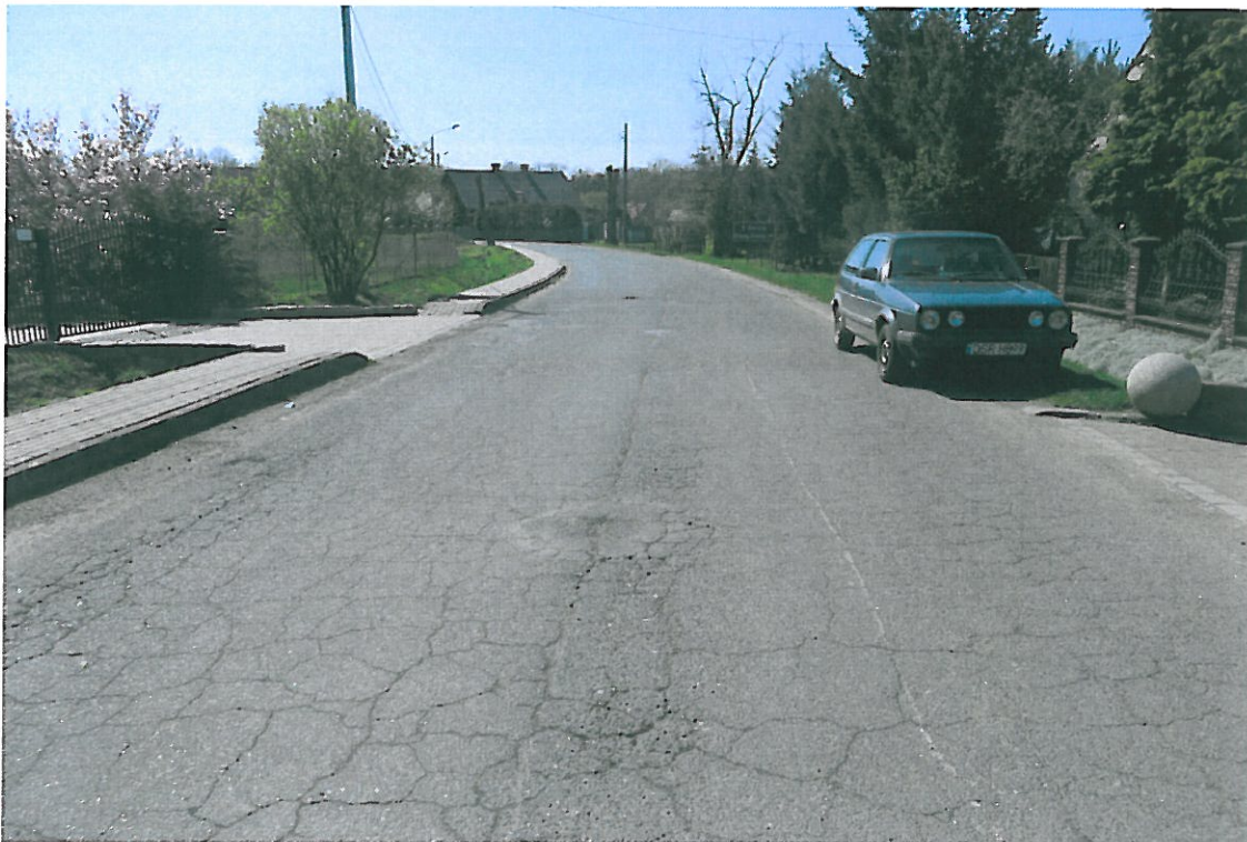
Fot . 122. Widok odcinka drogi Księginice, km 8+100.
