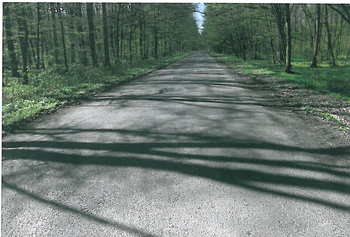
Fot . 94. Widok odcinka drogi Lenartowice - Księginice, km 6+900.
