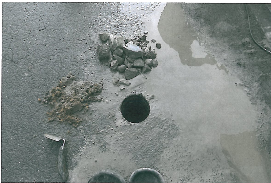
Fot . 99. Widok odkrywki Nr 17 w km 4+700.
