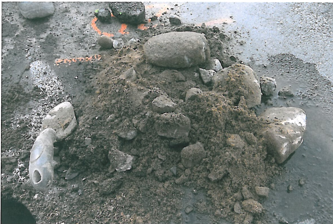
Fot . 56. Widok kruszywa z podbudowy i podsypki odkrywki Nr 10 w km 2+000,
