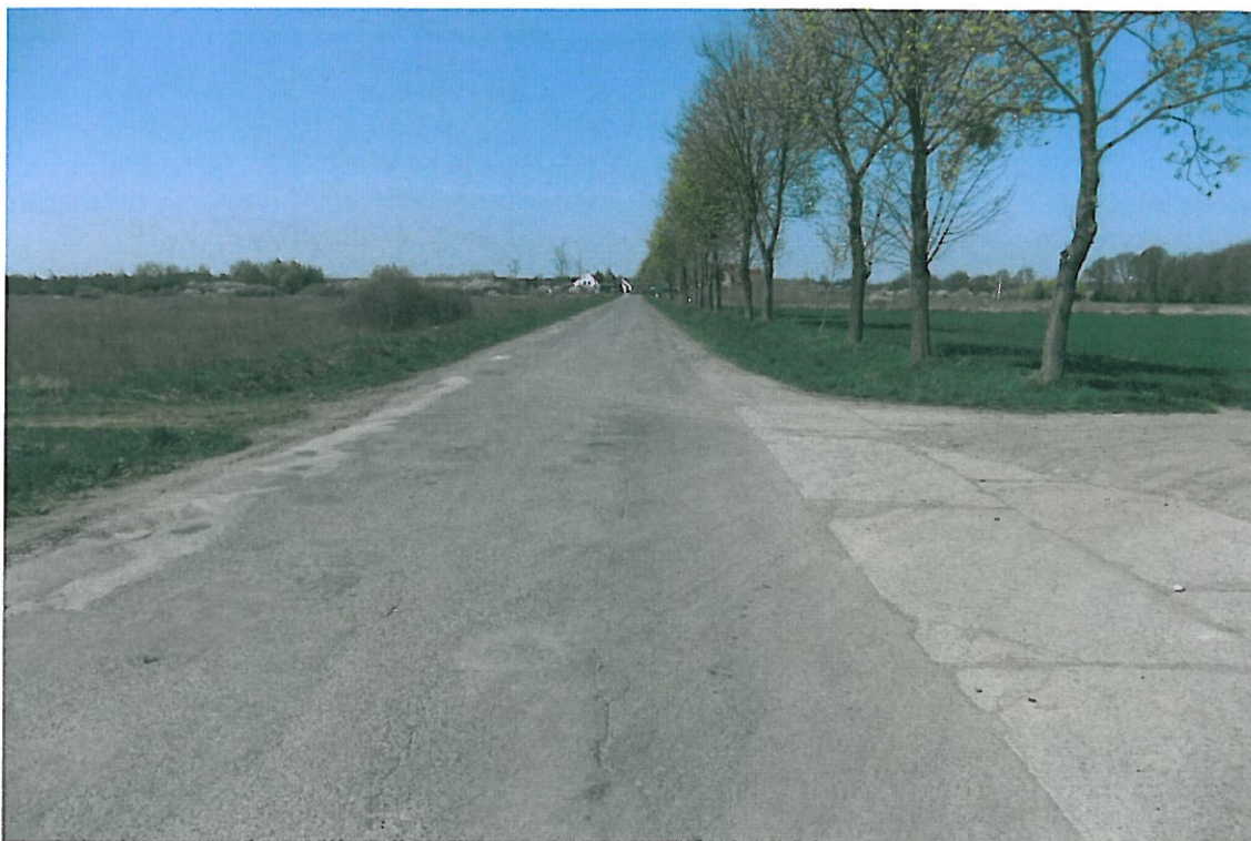
Fot . 66. Widok odcinka drogi Prężyce - Lenartowice, km 4+200.
