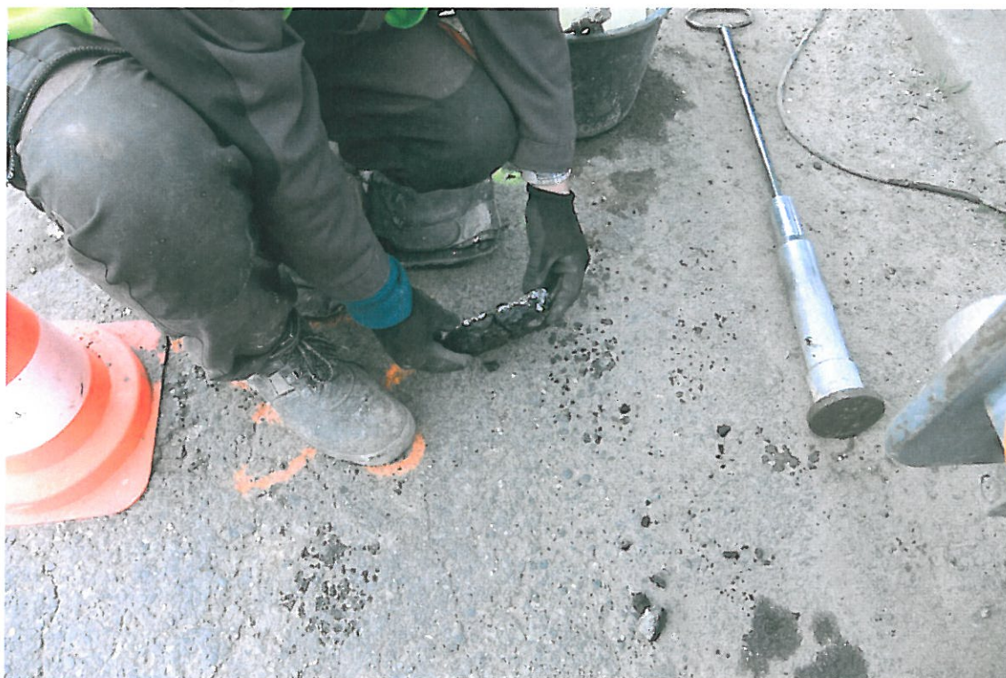
Fot . 41. Widok odwierconych warstw bitumicznych, odkrytki Nr 6 w km 0+700, pas lewy
