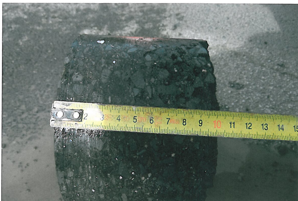
Fot . 74. Widok odwiertu Nr 12 w km 2+700, pas prawy
