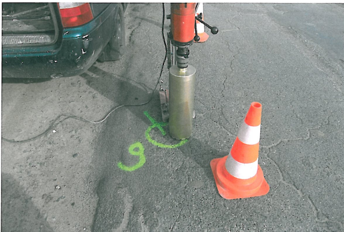
Fot . 51. Lokalizacja odkrywki Nr 9 w km 1+700 pas lewy
