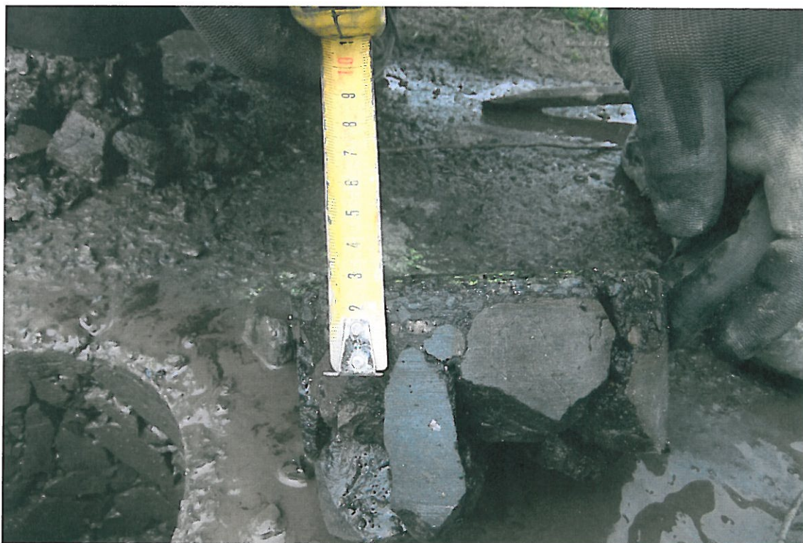
Fot . 112. Widok próbki kruszywa z podbudowy, odwiertu Nr 22 w km 6+360, pas prawy
