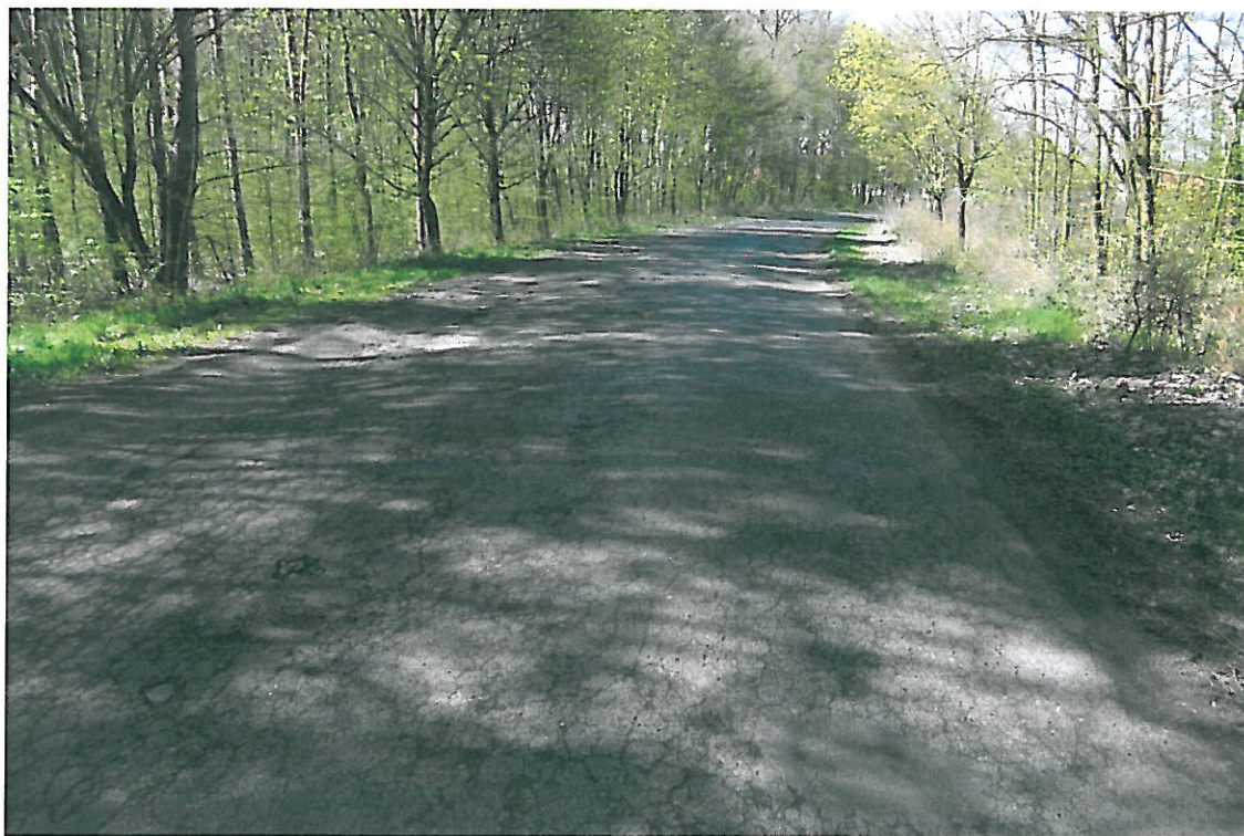
Fot . 118. Widok odcinka drogi Księginice, km 7+300.
