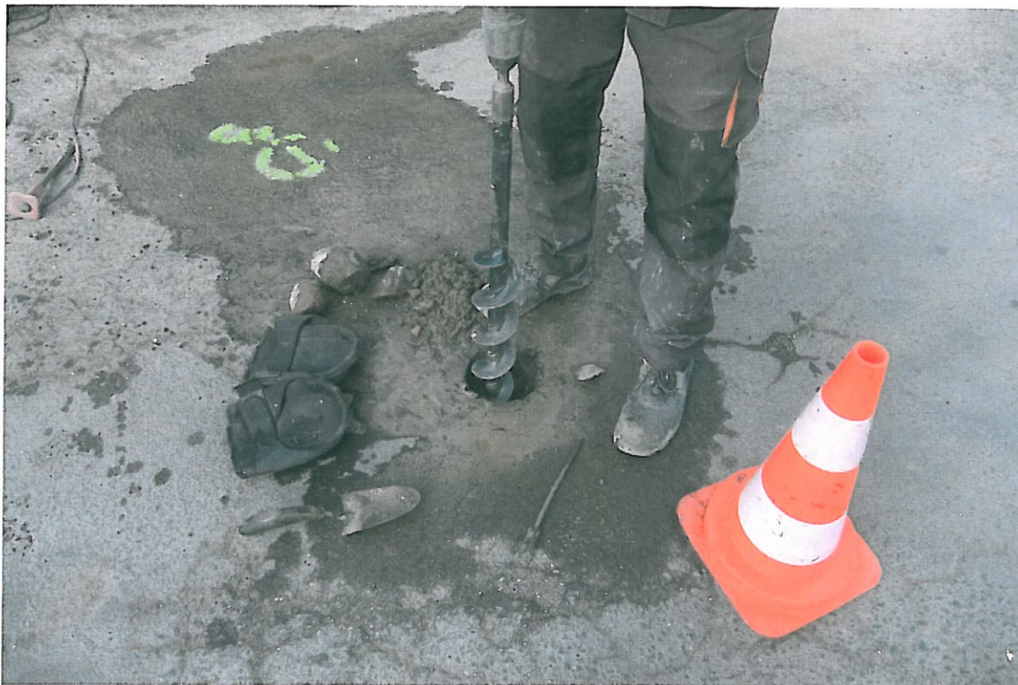
Fot . 18. Widok odkrywki Nr 3 w km 0+750, odwiert z bruku z i pobieranie próbki z podbudowy.
