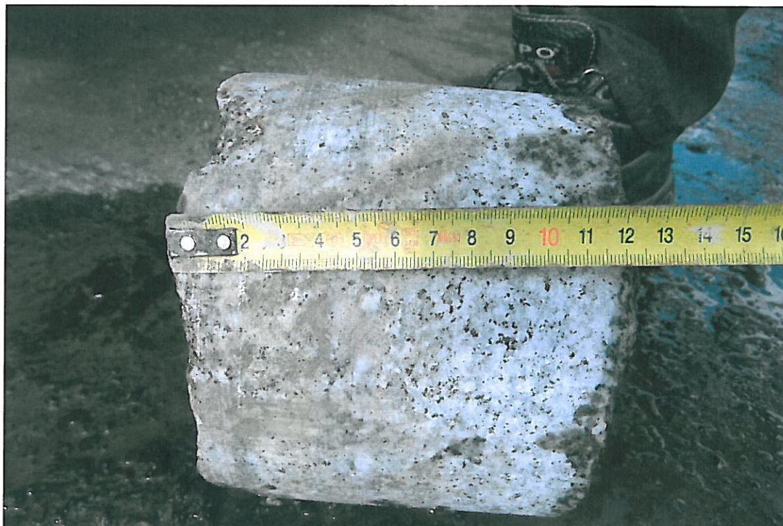
Fot .38. Widok próbki odwierconego bruku odkrywki Nr 5 w km 0+400
