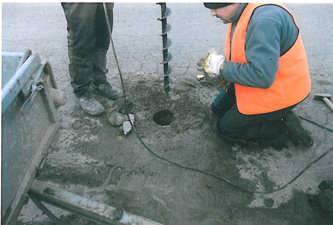
Fot . 14. Widok odkrywki Nr 2 w km 0+360, pobieranie próbki z podsypki
