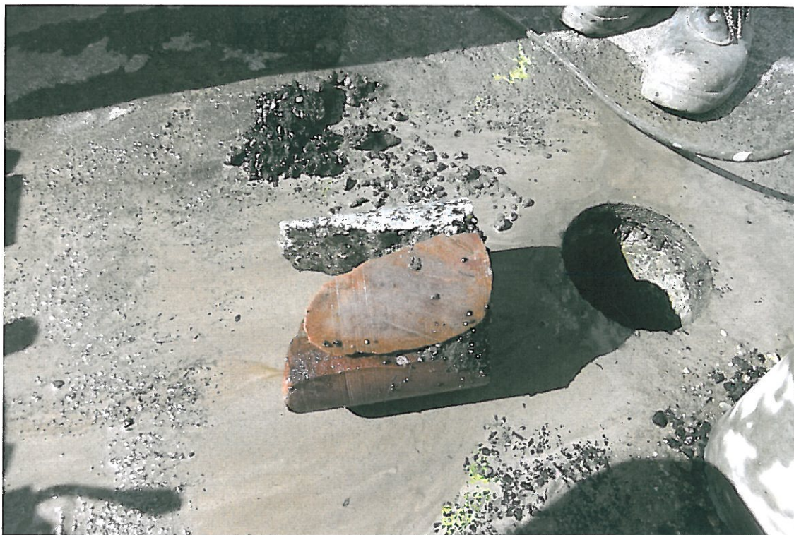
Fot . 42. Widok próbki odwierconego bruku odkrywki Nr 6 w km 0+700
