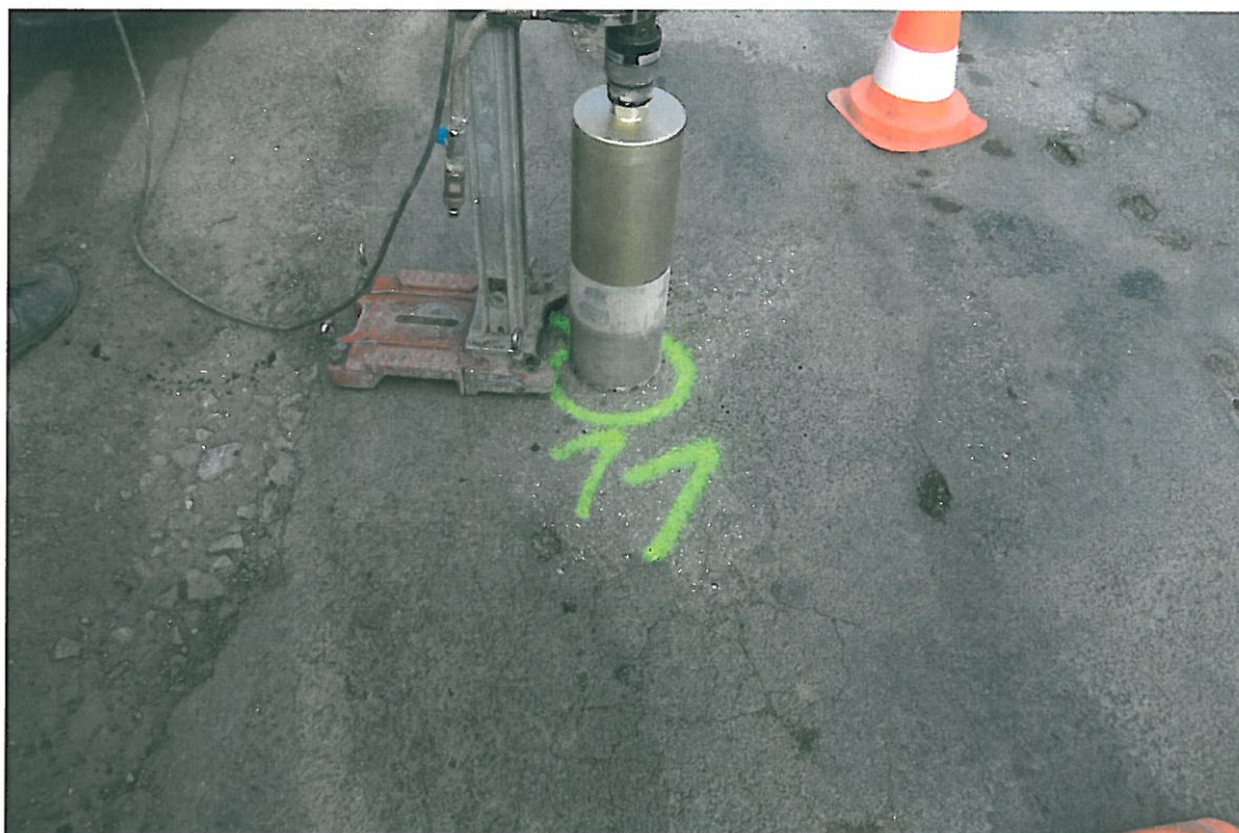
Fot . 69. Lokalizacja odkrywki Nr 11 w km 2+400, pas lewy
