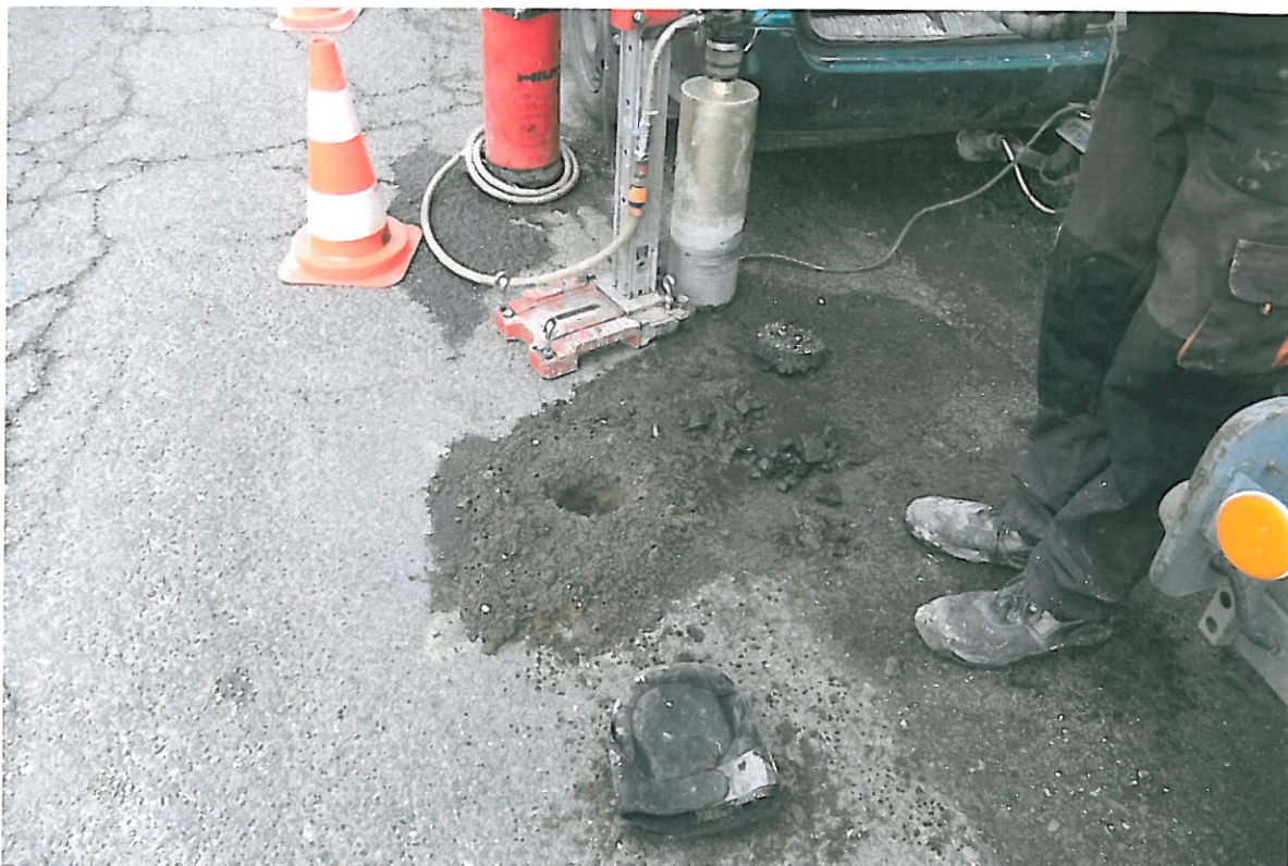
Fot . 107. Widok próbki z pospółki odwiertu Nr 20 w km 5+650, pas prawy
