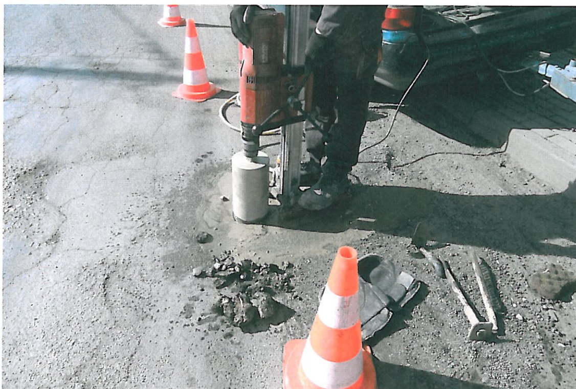
Fot . 131. Widok próbki kruszywa z podbudowy, odwiertu Nr 26 w km 7+740, pas prawy
