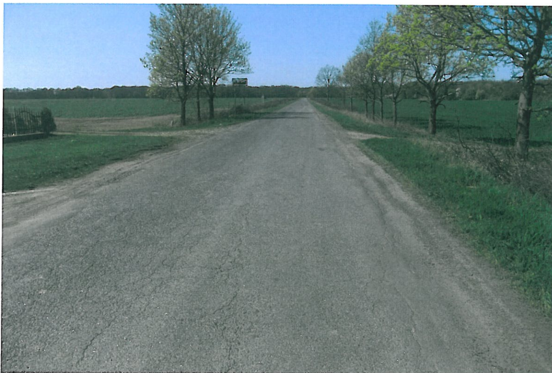
Fot . 88. Widok odcinka drogi Lenartowice - Księginice, km 5+700.
