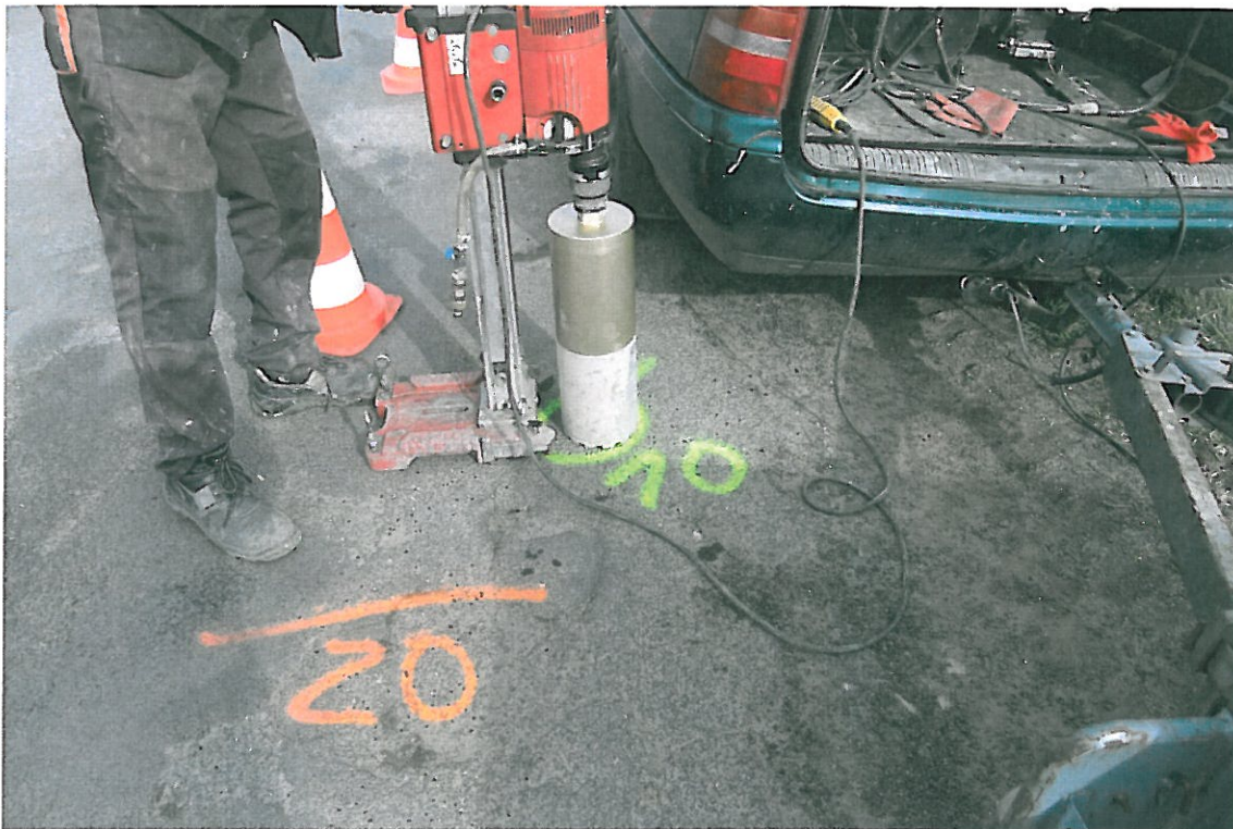
Fot . 54. Lokalizacja odkrywki Nr 10 w km 2+000 pas prawy
