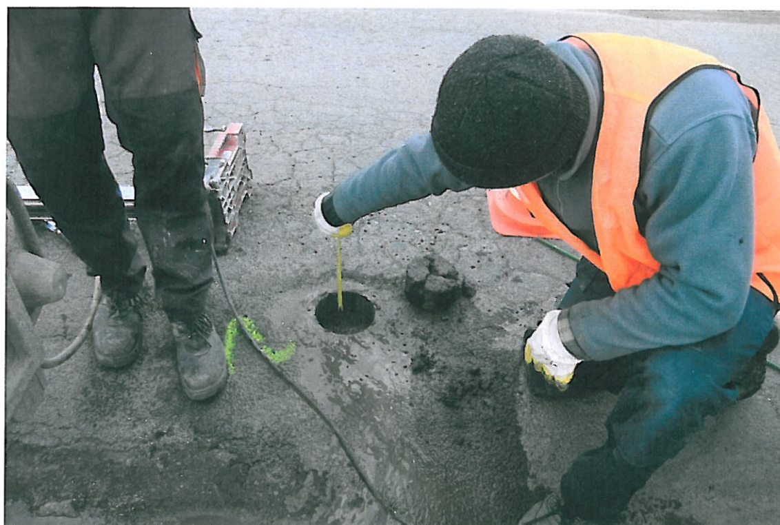
Fot . 12. Widok odwiertu Nr 2 w km 0+360, pas prawy
