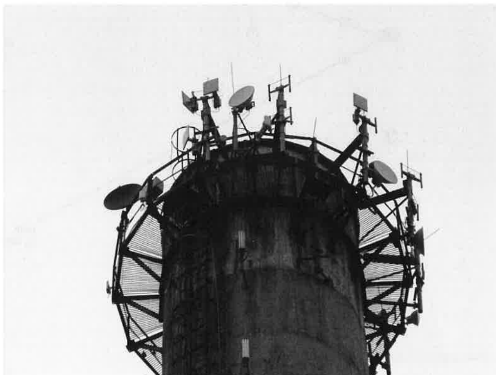
Widok instalacji radiokomunikacyjnej Stacja Netia MALCD004 - MALCM00001 Malczyce, ul. Sienkiewicza 25.
