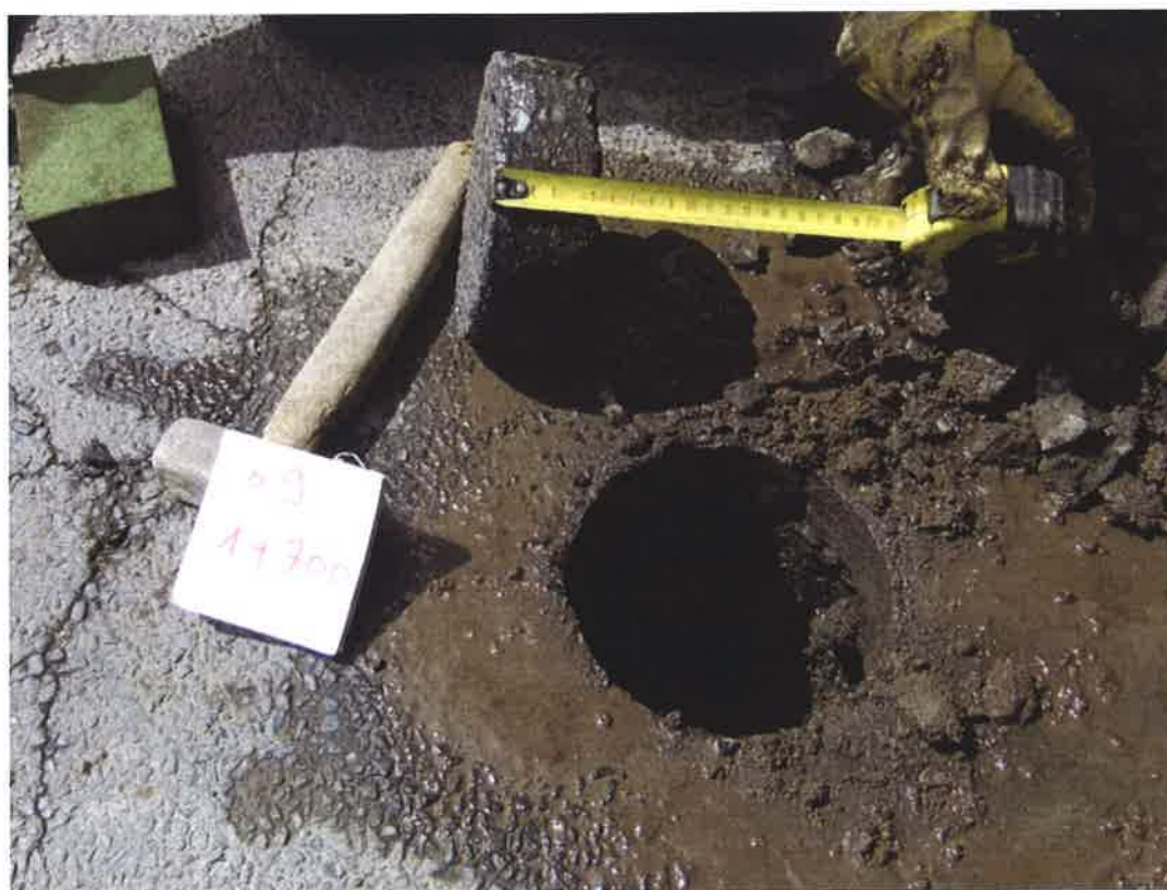
Fot . 22. Widok odkrywyki Nr 9 w km 1+700
