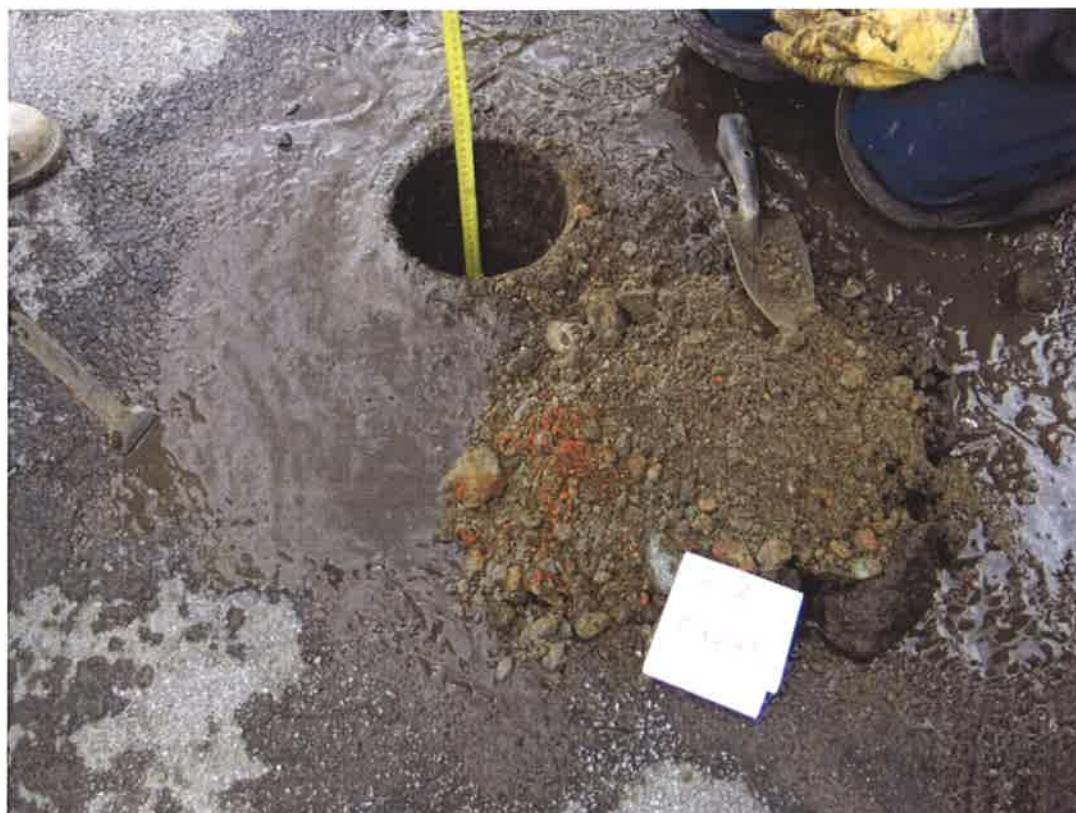
Fot . 14. Widok odkrywki Nr 3 w km 0+675
