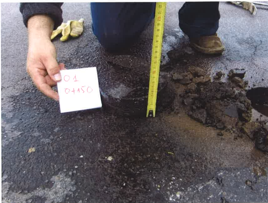
Fot . 8. Widok odwiertu Nr 1 w km 0+150
