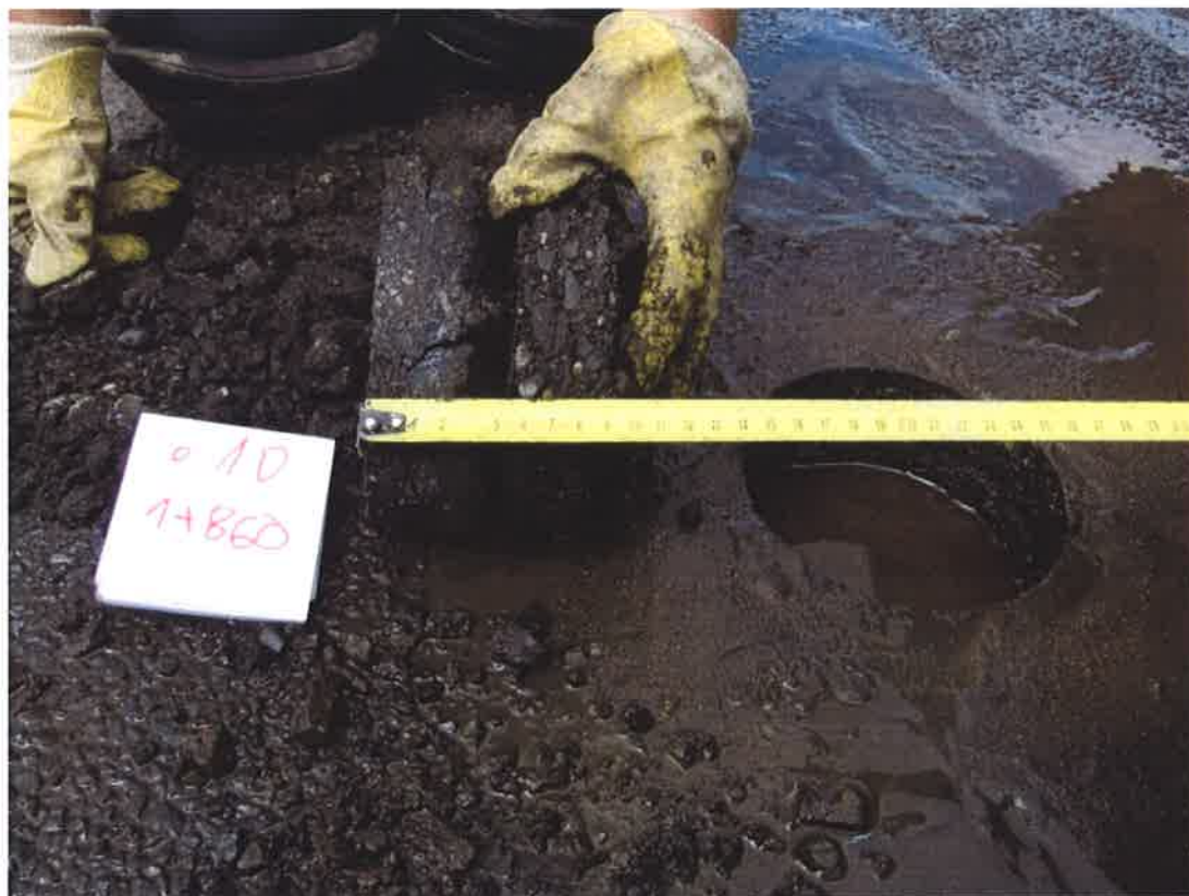
Fot . 23. Widok odkrywki Nr 10 w km 1+860
