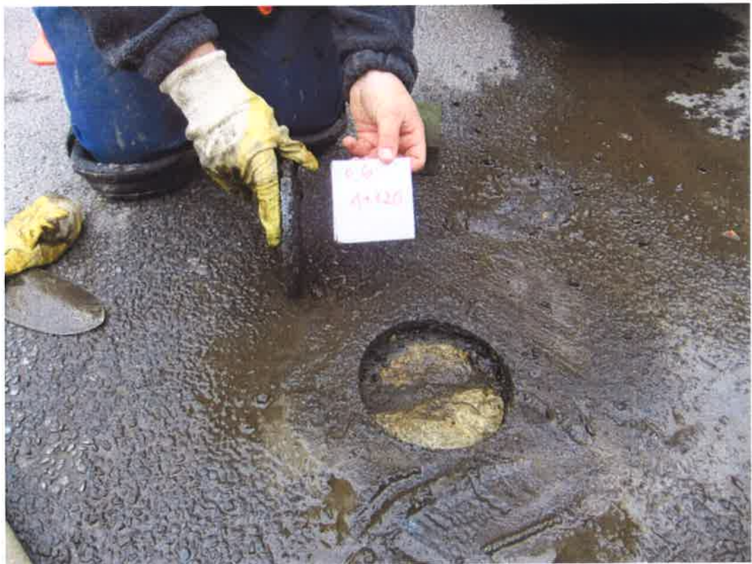
Fot . 19. Widok odkrywki Nr 6 w km 1+120
