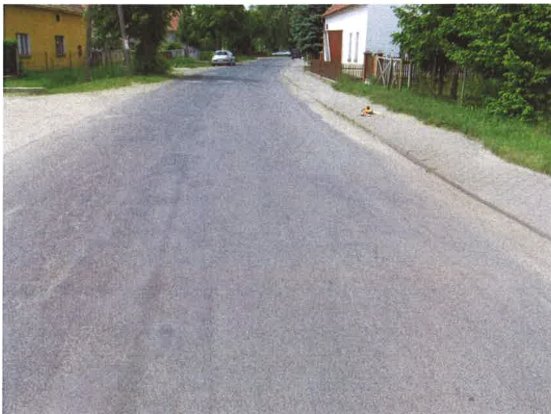
Fot . 6. Widok ulicy Wyzwolenia w rejonie km 1+700
