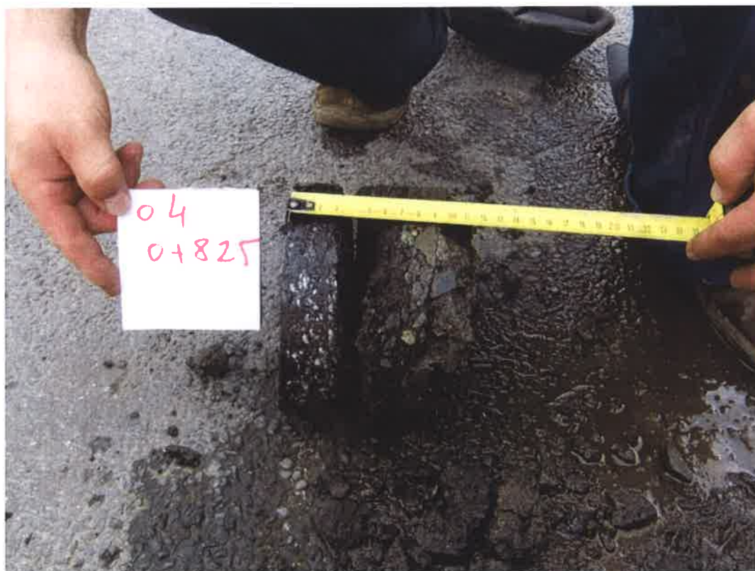
Fot . 15. Widok odkrywyki Nr 4 w km 0+825
