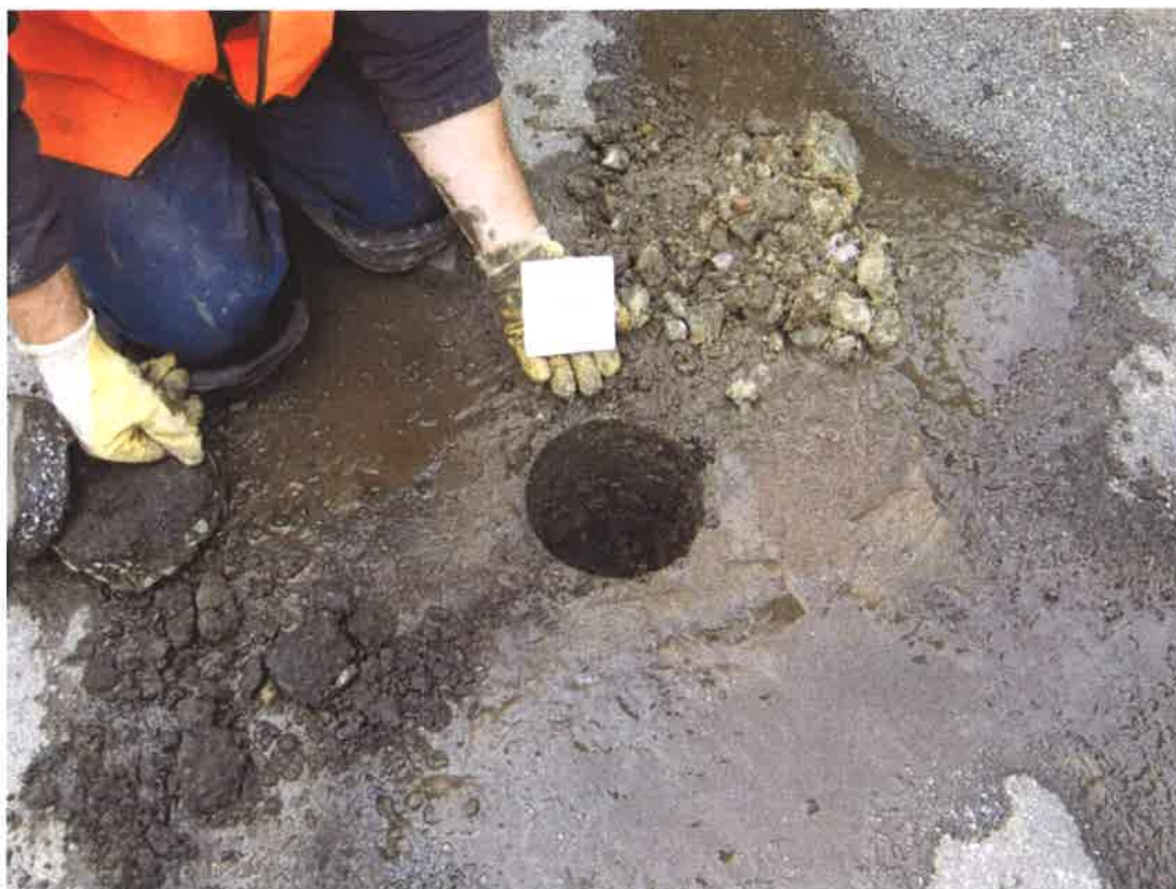
Fot . 16. Widok odkrywki Nr 4 w km 0+825
