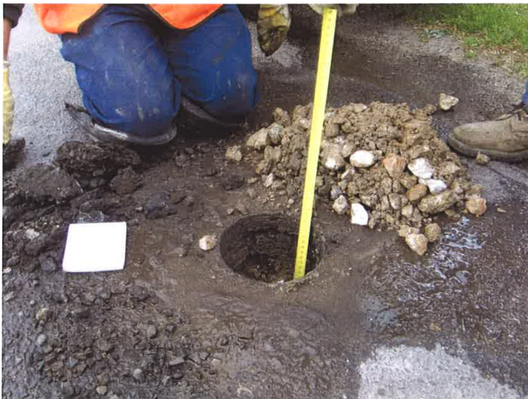
Fot . 24. Widok odkrywki Nr 10 w km 1+860
