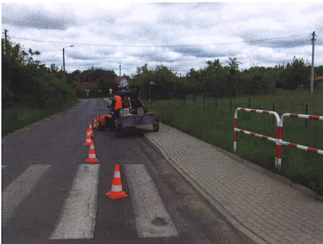
Fot . 3. Widok ulicy Wyzwolenia w rejonie km 0+675
