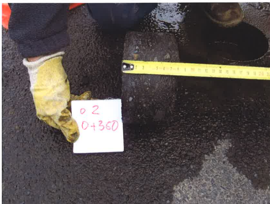
Fot . 11. Widok odkrywki Nr 2 w km 0+360
