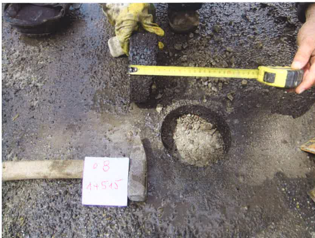
Fot . 21. Widok odkrywki Nr 8 w km 1+515
