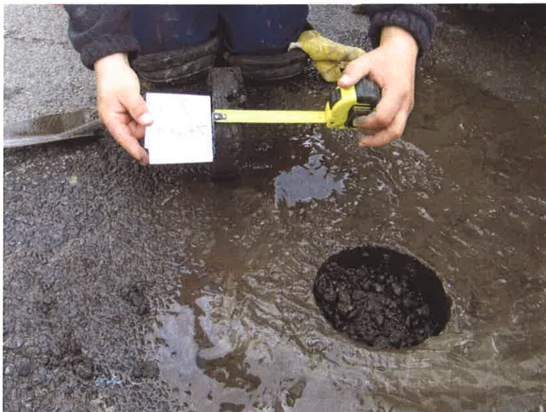
Fot . 13. Widok odkrywki Nr 3 w km 0+675
