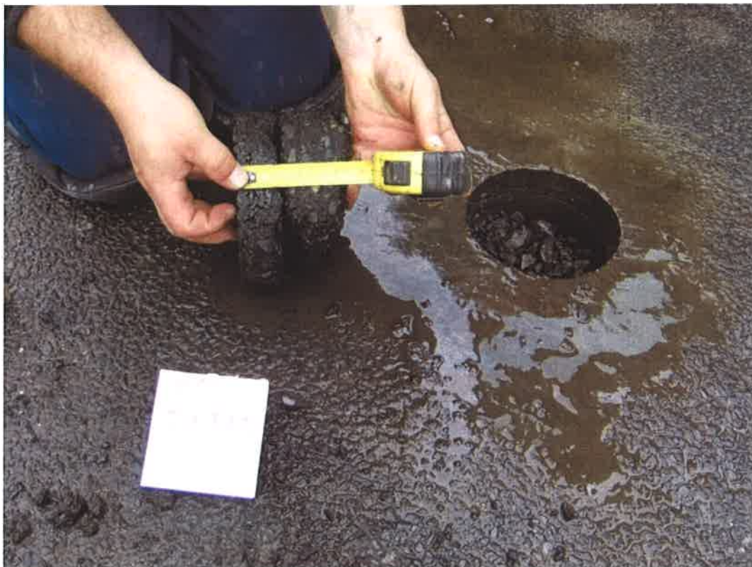
Fot . 17. Widok odkrywki Nr 5 w km 0+910
