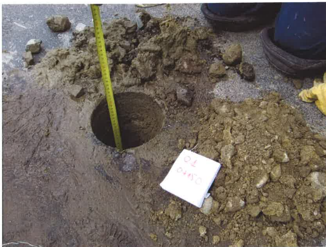
Fot . 9. Widok odkrywki Nr 1 w km 0+150
