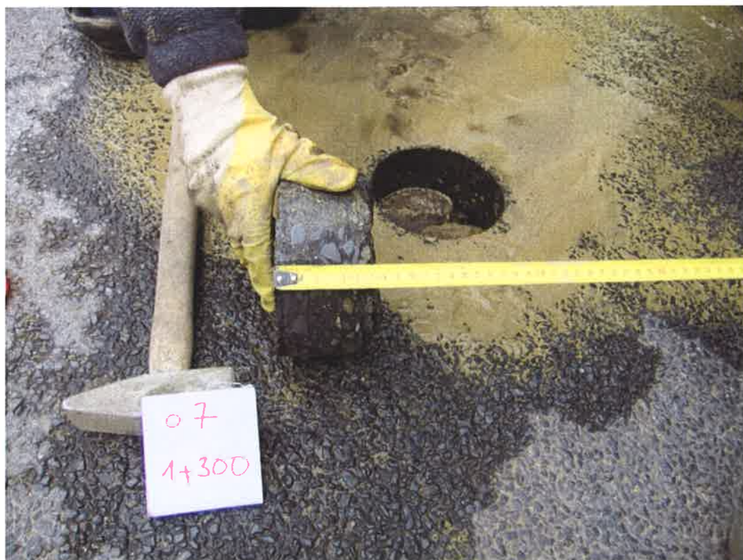
Fot . 20. Widok odkrywki Nr 7 w km 1+300
