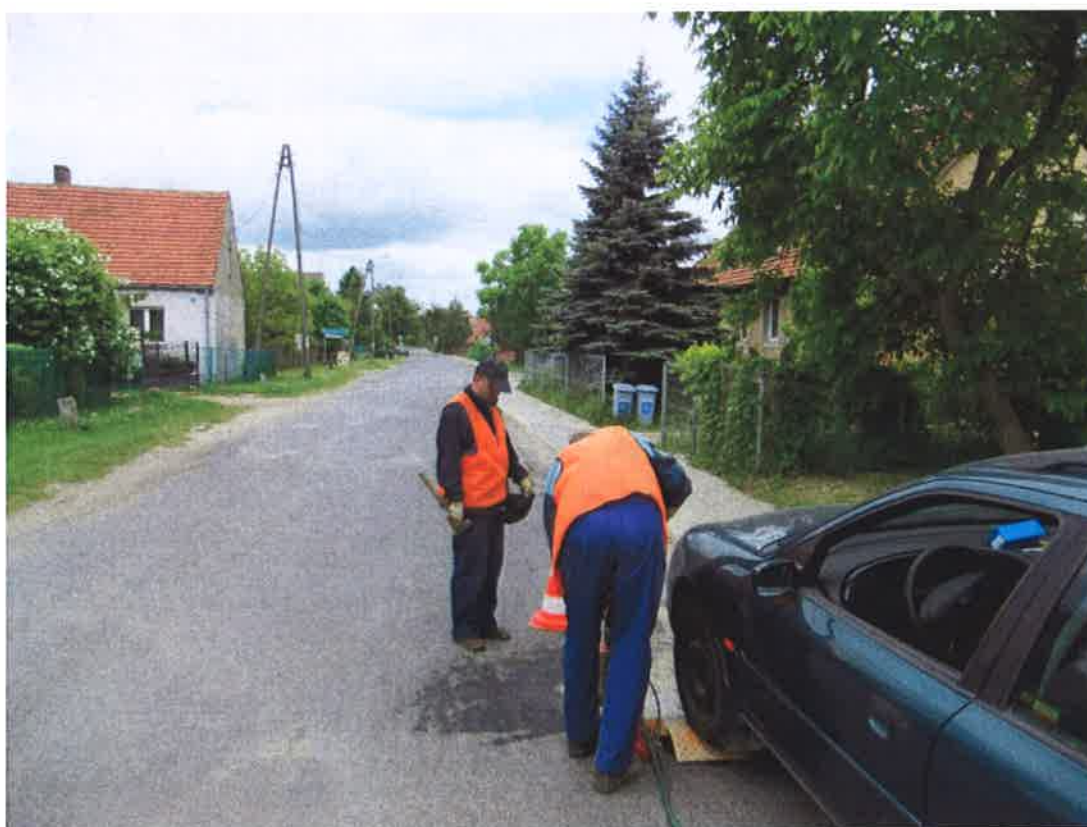
Fot . 5. Widok ulicy Wyzwolenia w rejonie km 1+120
