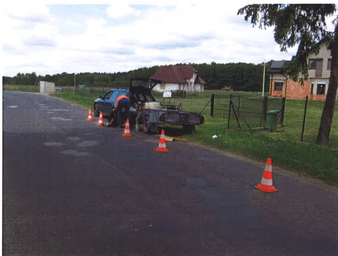
Fot . 7. Widok ulicy Piastowskiej w rejonie km 1+860
