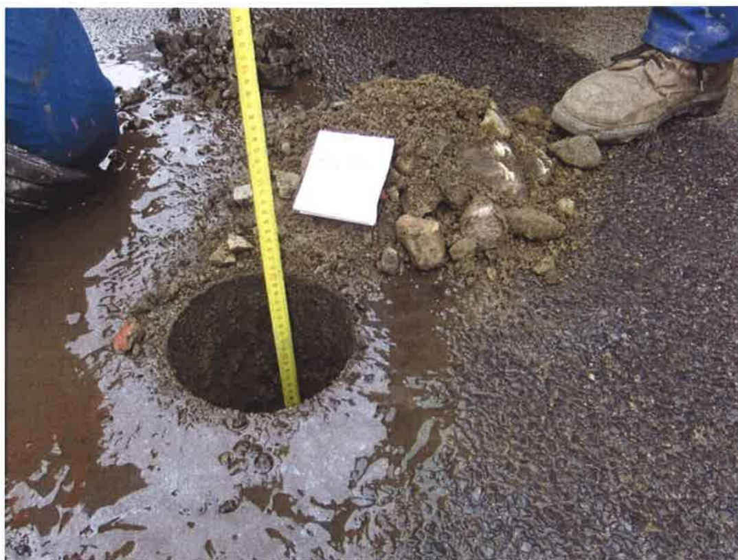
Fot . 18. Widok odkrywki Nr 5 w km 0+910
