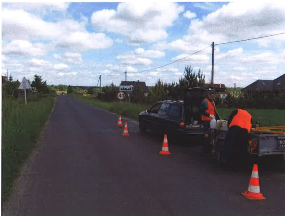
Fot . 2. Widok ul. Wyzwolenia w rejonie km 0+150
