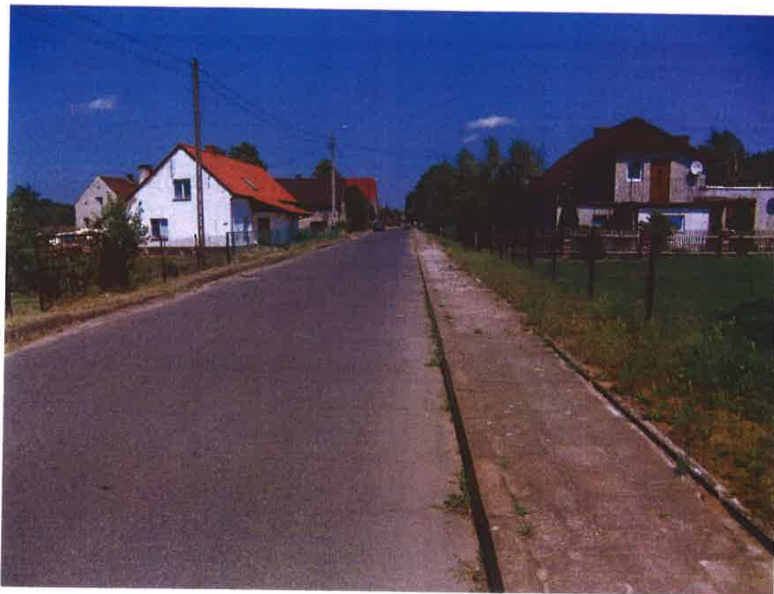
Fot. 12. Widok nawierzchni drogi w Wojnowicach, km 1 + 700
