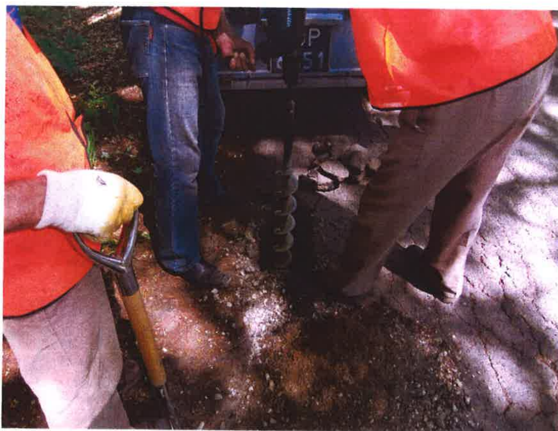
Fot. 16. Widok odwiertu Nr 4 ( km 1 + 400 )
