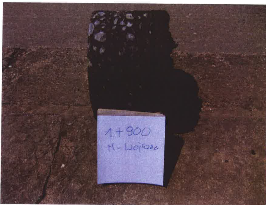
Fot. 20. Widok odwiertu Nr 5 ( km 1 + 900 )
