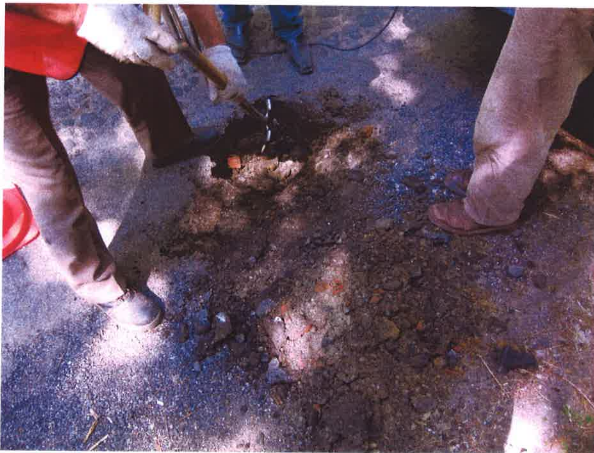
Fot. 15. Widok odkrywki Nr 3 ( km 0 + 900 )
