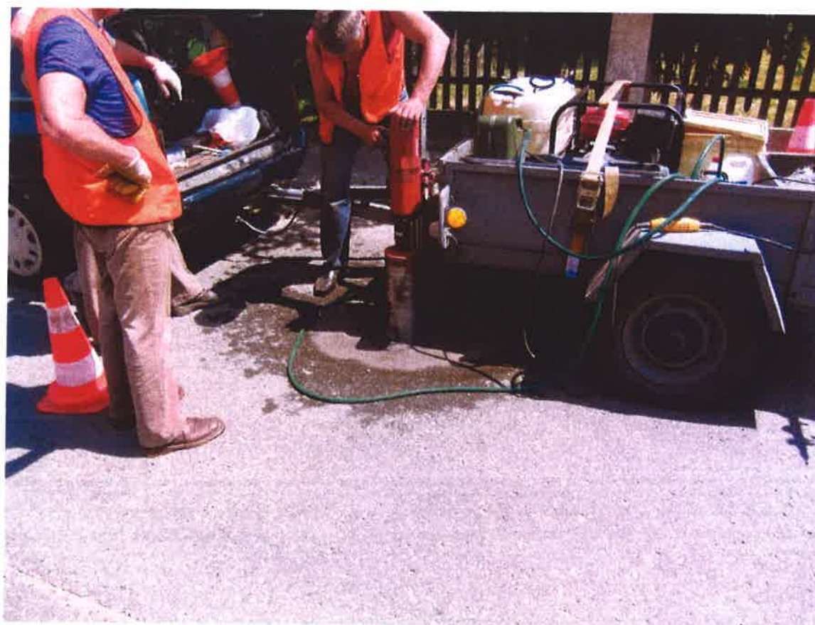
Fot. 17. Pobieranie odwiertu Nr 5 ( km 1 + 900 )
