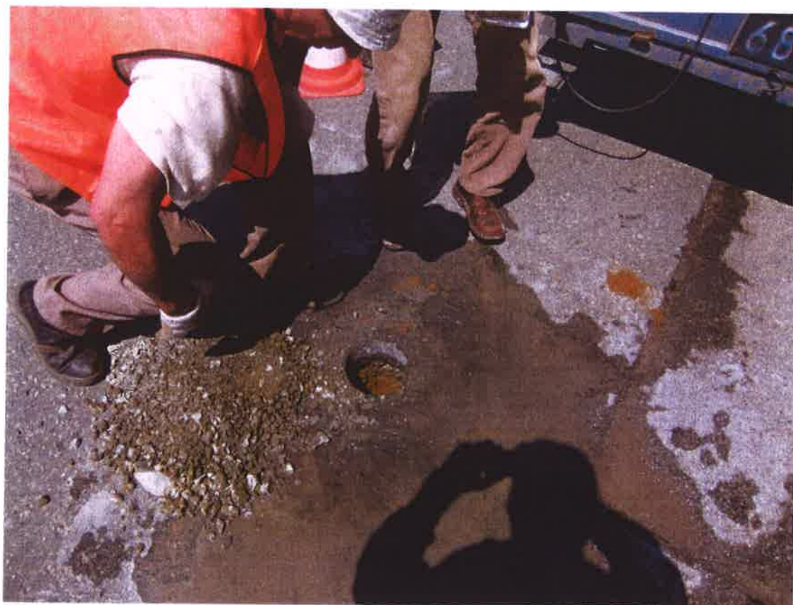
Fot. 19. Kruszywo podbudowy odwiertu Nr 5 ( km 1 + 900 )
