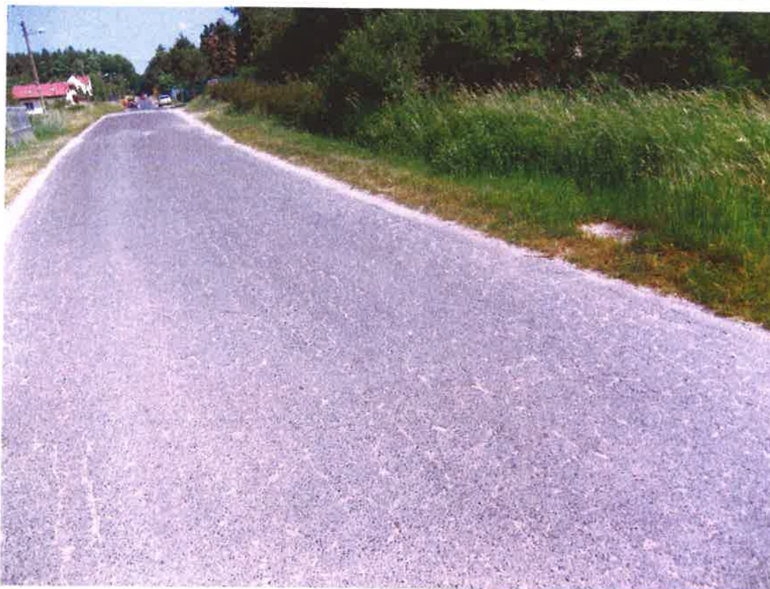
Fot . 2. Widok drogi Mrozów – Wojnowice w rejonie km 0+200
