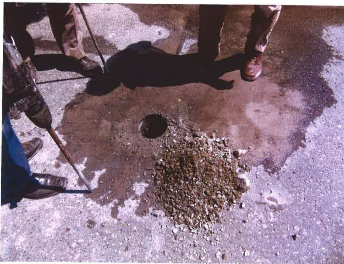
Fot. 18. Kruszywo podbudowy odwiertu Nr 5 ( km 1 + 900 )
