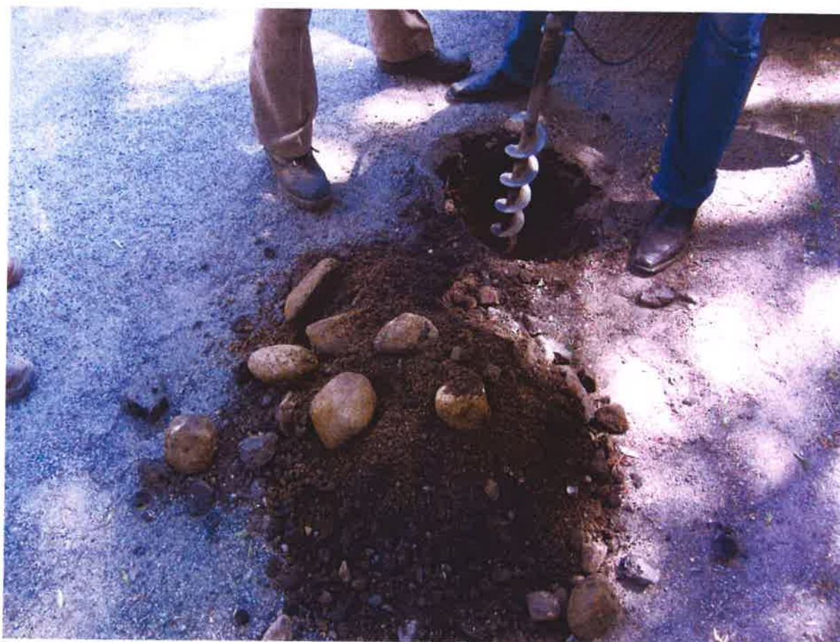
Fot. 13. Widok odkrywki Nr 1 ( km 0 + 100, strona prawa )
