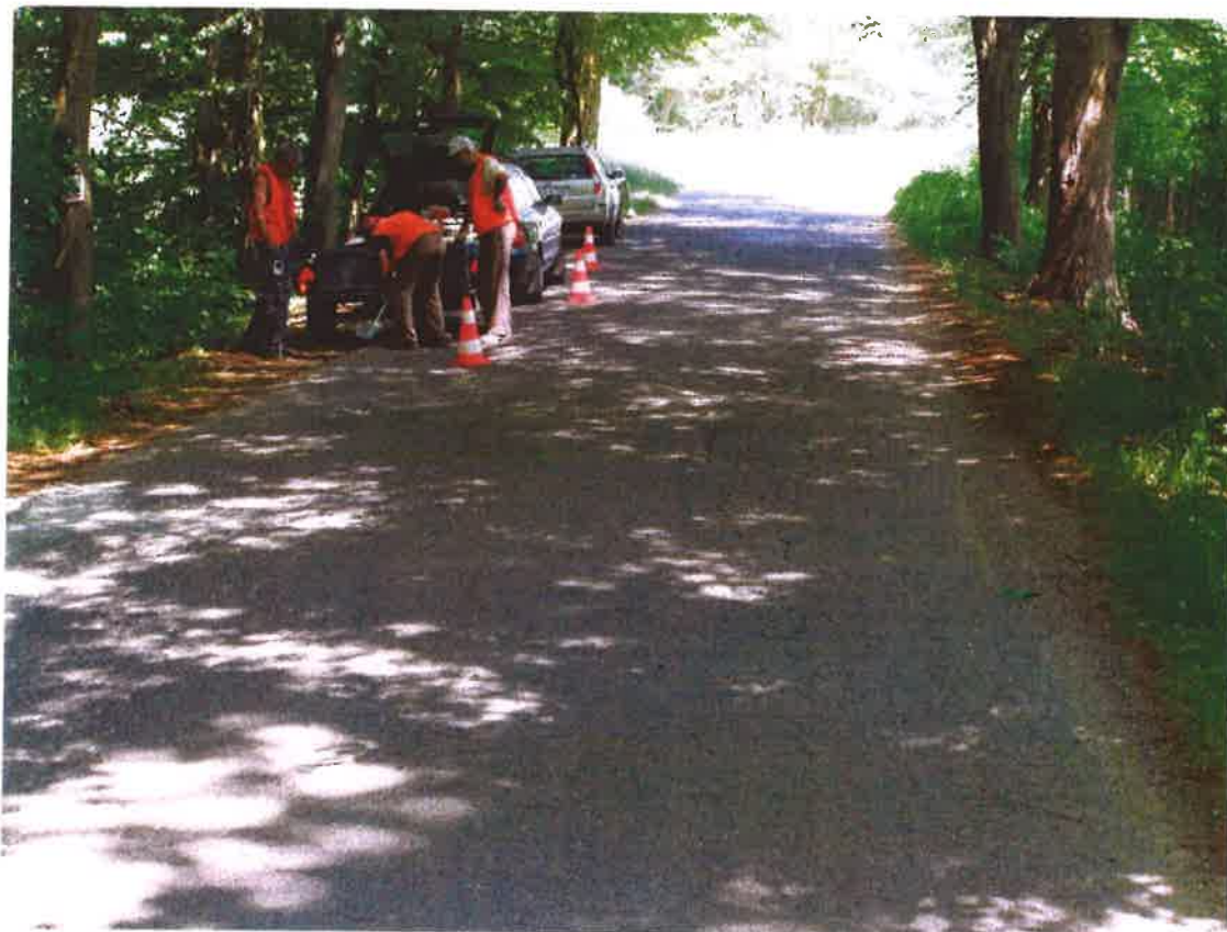
Fot. 10. Spękania nawierzchni drogi w rejonie km 1 + 350
